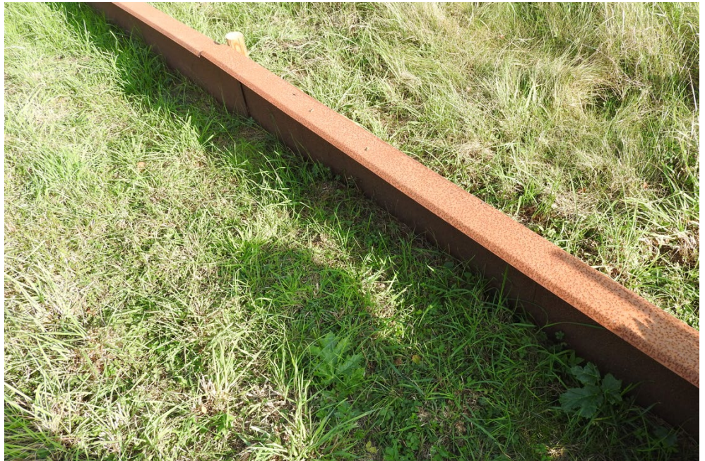
Figur 10-5 Eksempel på midlertidigt paddehegn i stål med bukket kant i toppen.
