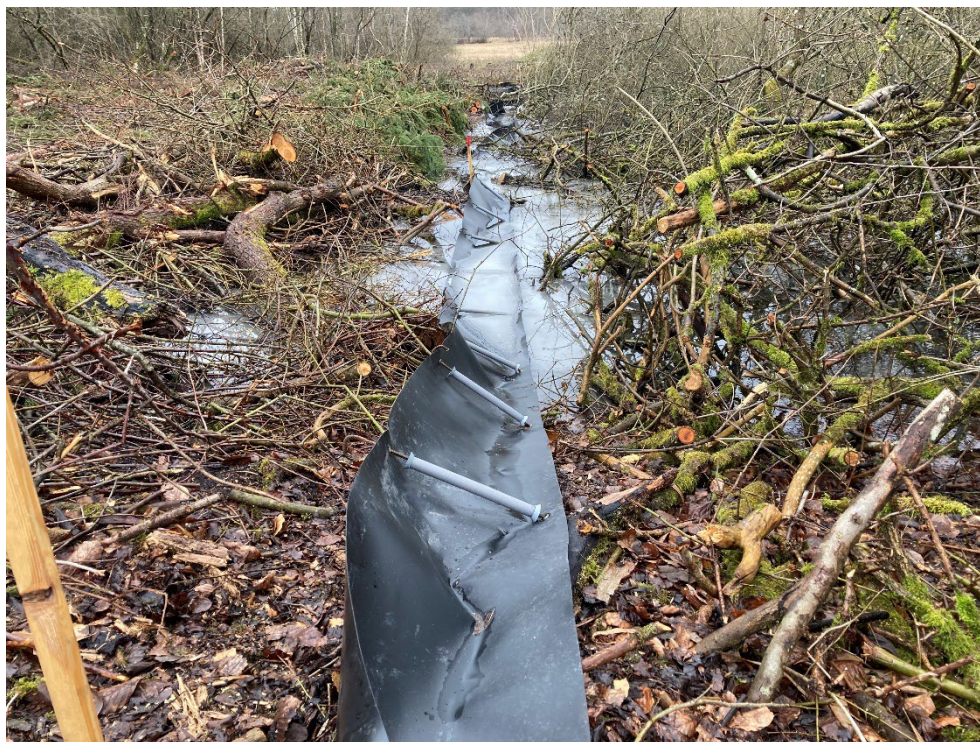
Figur 10-8 Et eksempel på et væltet paddehegn som nemt kan forceres af padder
