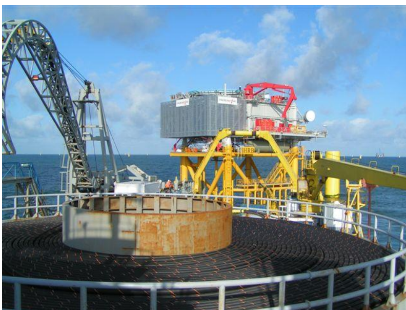
Figur 4-2 Installation av kablar från kabellägningsfartyg vid Anholt (Foto: Ramboll).
