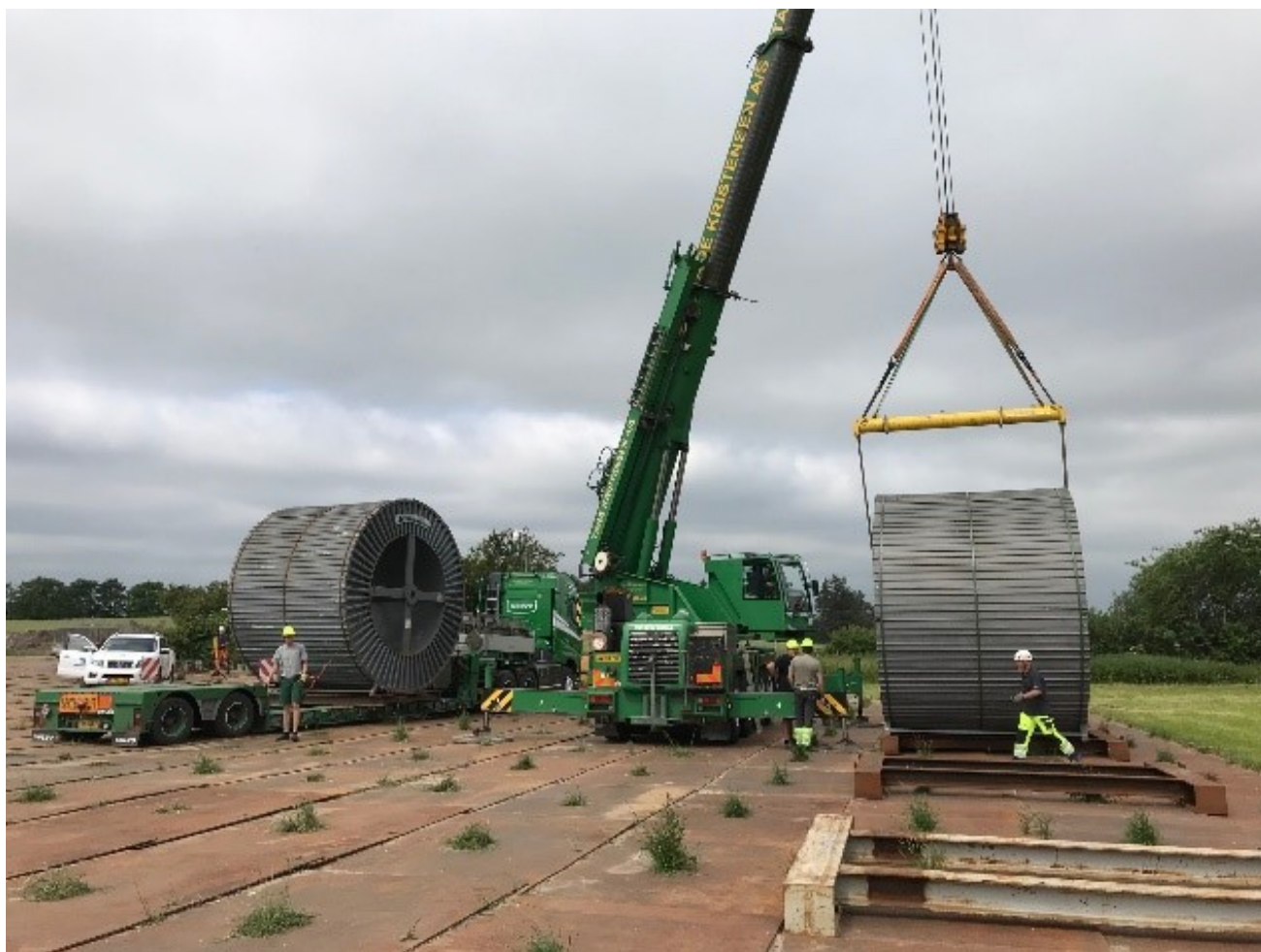
Figur 2-8 Håndtering af kabeltromler på tromleplads
