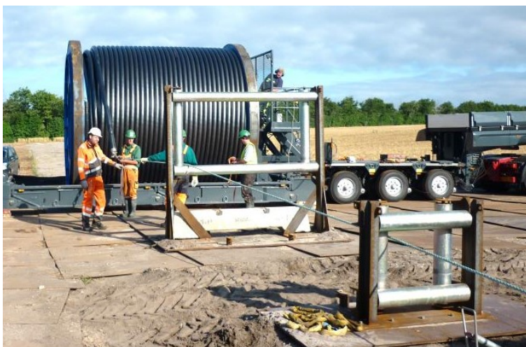
Figur 2-54 Kabeltromle på blokvogn
