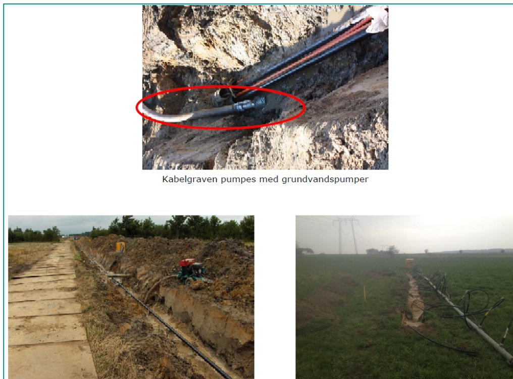
Figur 2-1 Forskellige metoder til at holde kabelgraven tør. På billedet til venstre etableres drænrør, til højre etableres sugspidsanlæg
