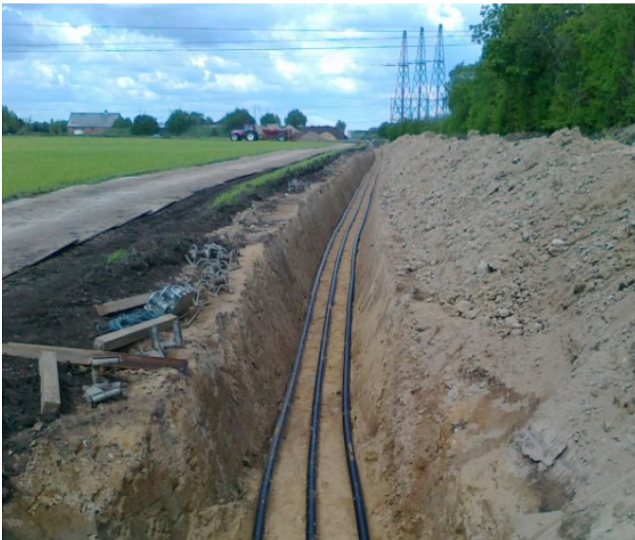
Figur 2-6 Kabelanlæg lagt ud i åben grav
