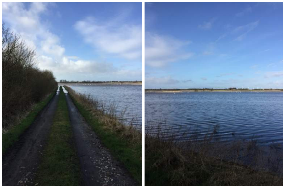
Figur 2-13 Oversvømmelse af projektområdet i februar 2020, langs adgangsvejen til Storå (Foto: Frederik Aagaard/COWI)
