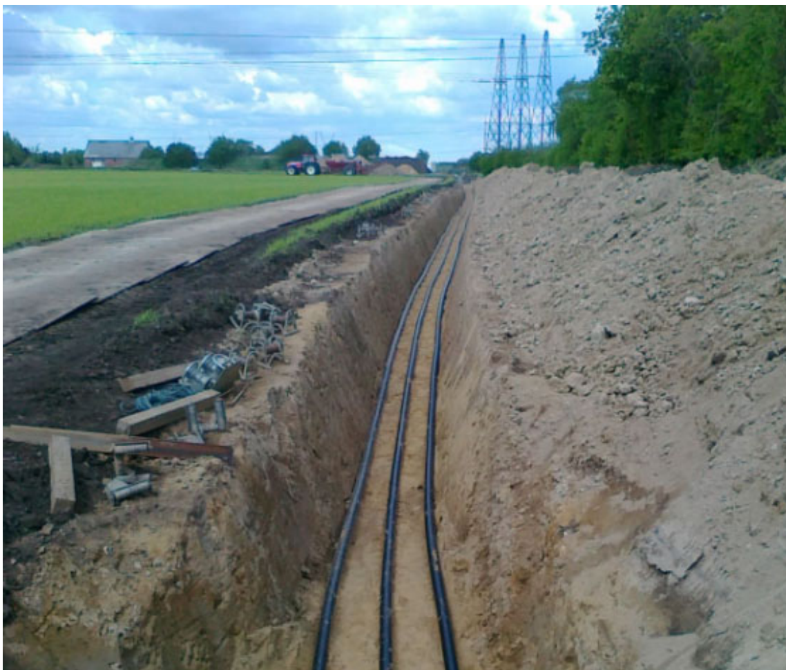
Figur 2–5 Åben kabelgrav med tre kabler trukket og placeret i flad forlægning.
