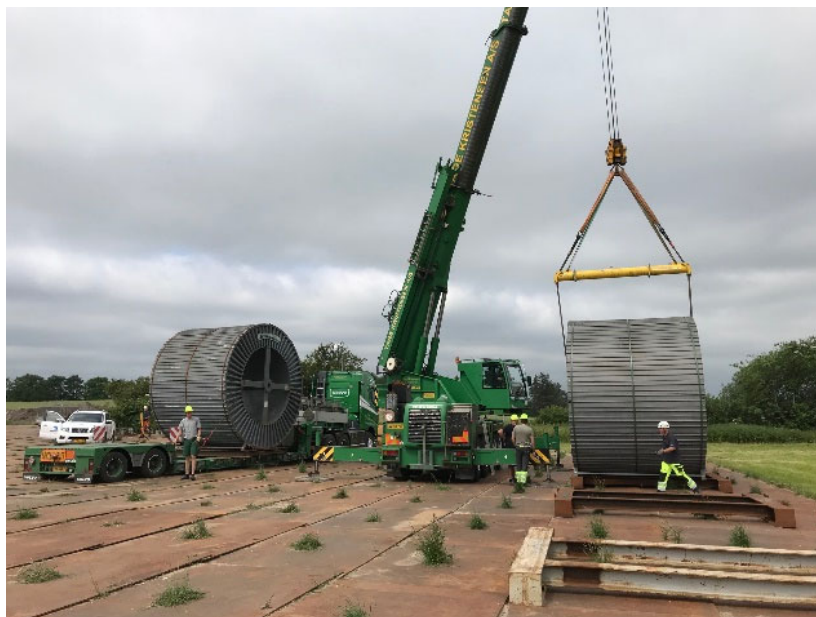
Figur 2-7 Eksempelfoto af håndtering af kabeltromler.
