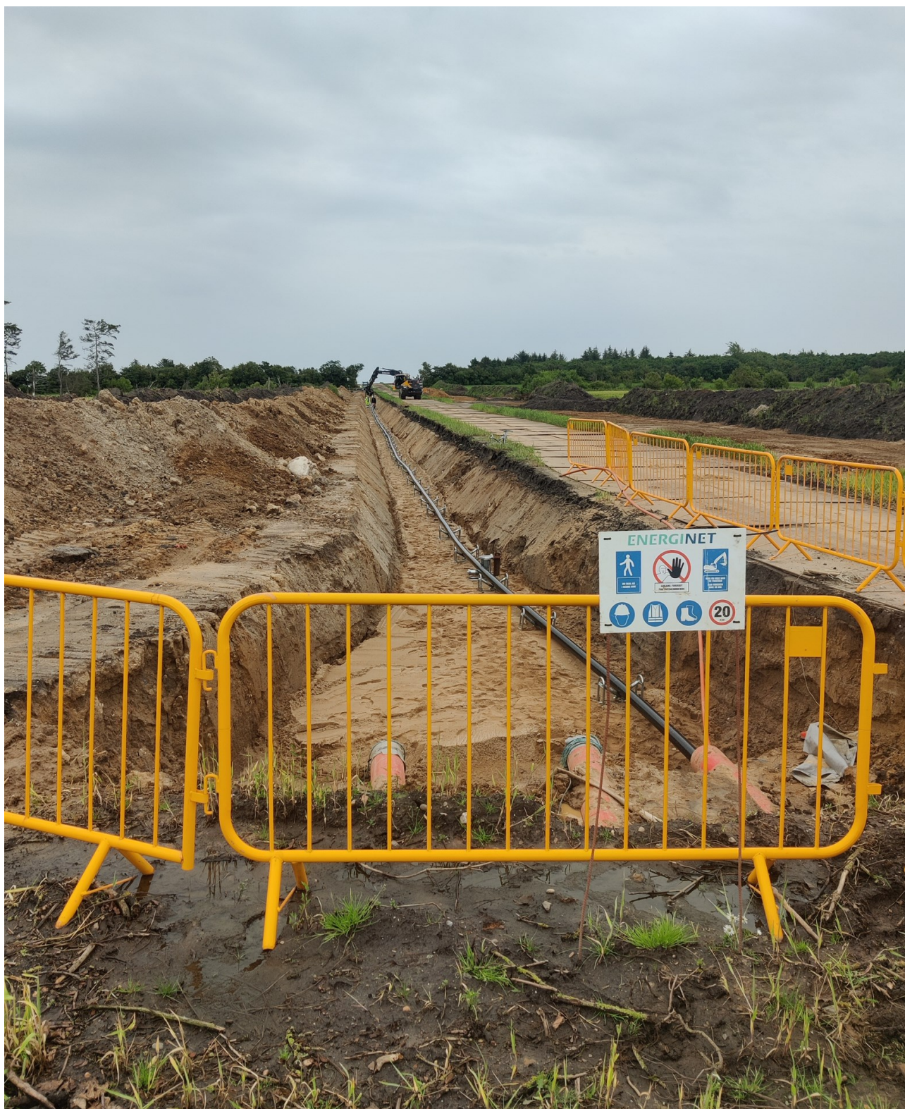
Figur 4-1. Sådan kan det se ud, når Energinet graver kablerne ned.
