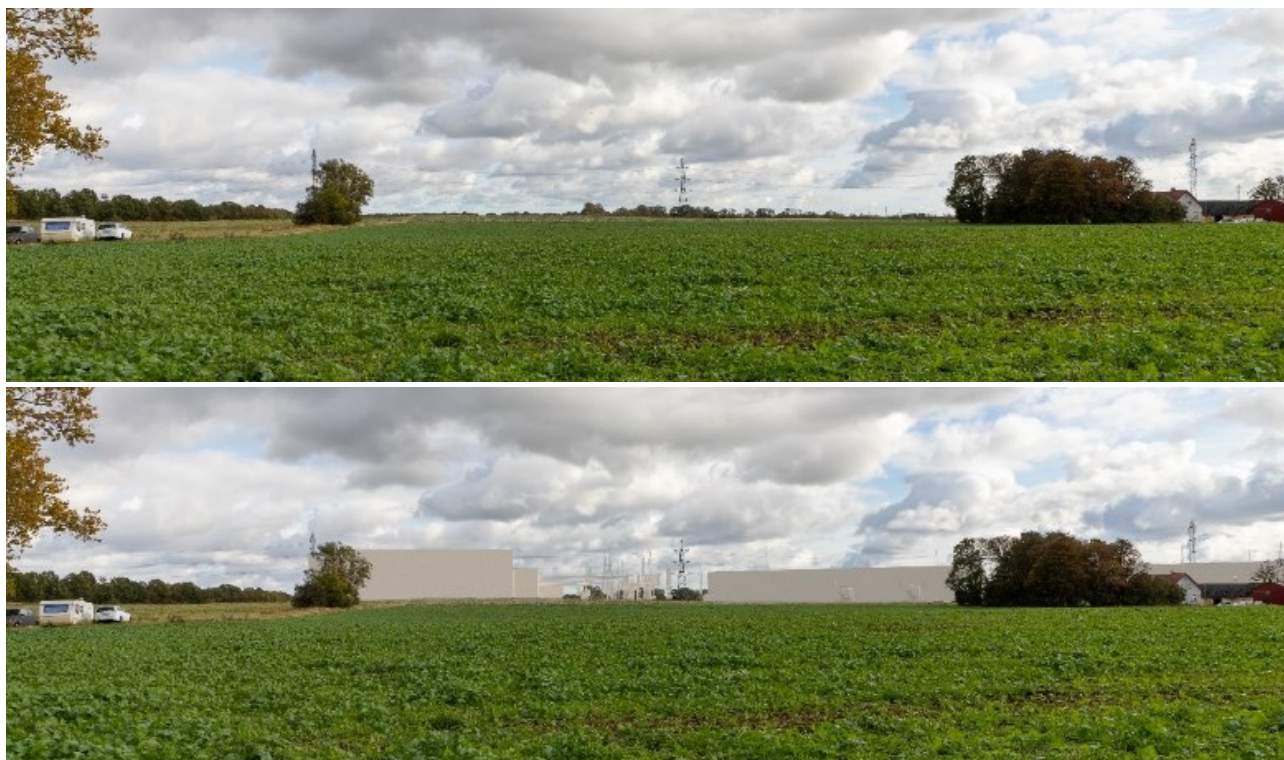
Figur 7-3. Eksisterende og fremtidige forhold set fra Solhøjvej vest for projektområdet, uden beplantning og terrænbearbejdning til at skjule anlægget. Se miljøkonsekvensrapporten Del 4 for en større version af billederne.
