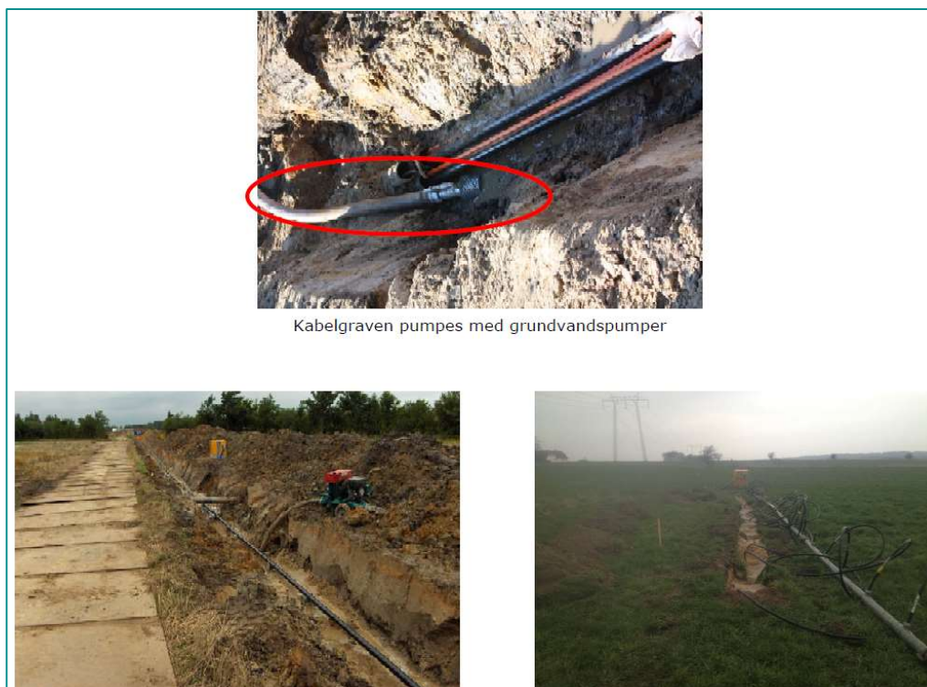
Figur 5.13. Forskellige metoder til at holde kabelgraven tør. På billedet til venstre etableres drænrør, til højre etableres sugespidsanlæg.
