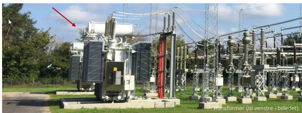
Figur 3.4. Eksempelfoto af transformere.
