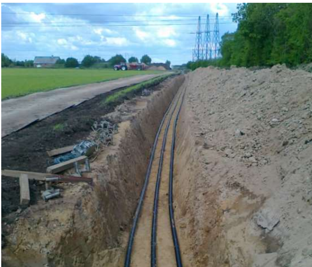
Figur 5.6. Kabelanlæg lagt ud i åben grav.
