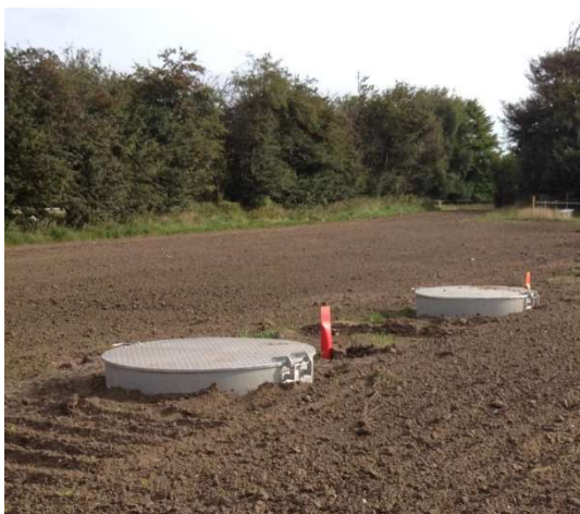
Figur 5.1. Eksempelfoto af jordingsbokse og markeringspæle i terræn.
