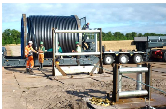
Figur 5.14 Kabeltromle på blokvogn.
