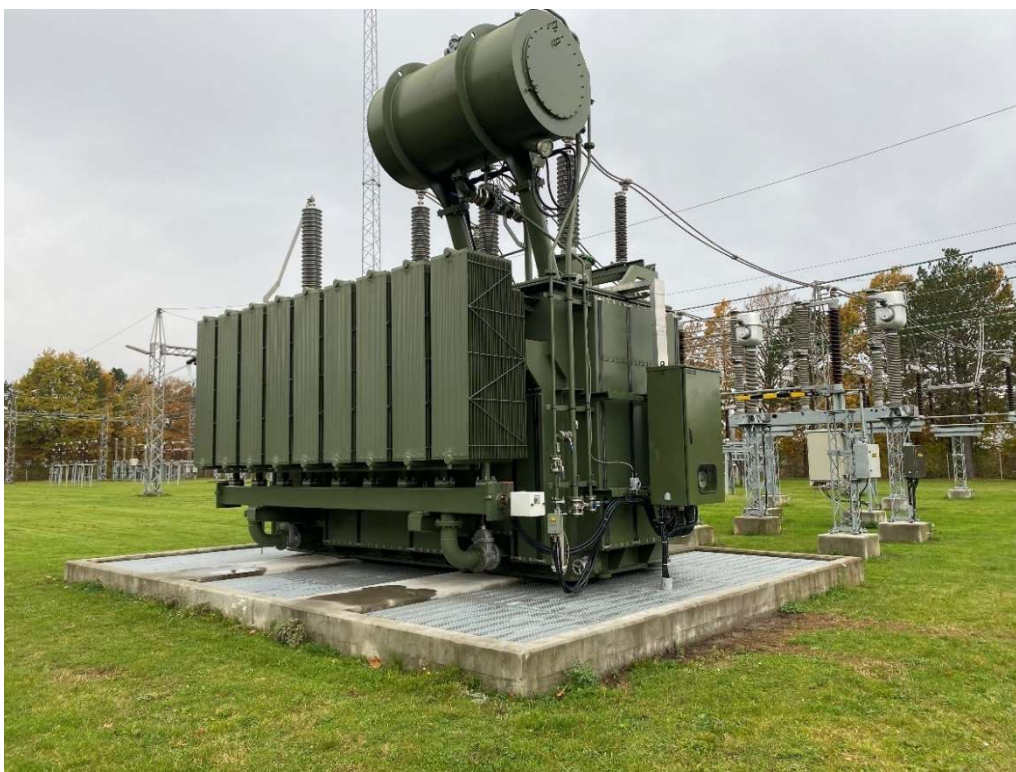
Figur 3.6. Eksempelfoto af 132 kV reaktor.
