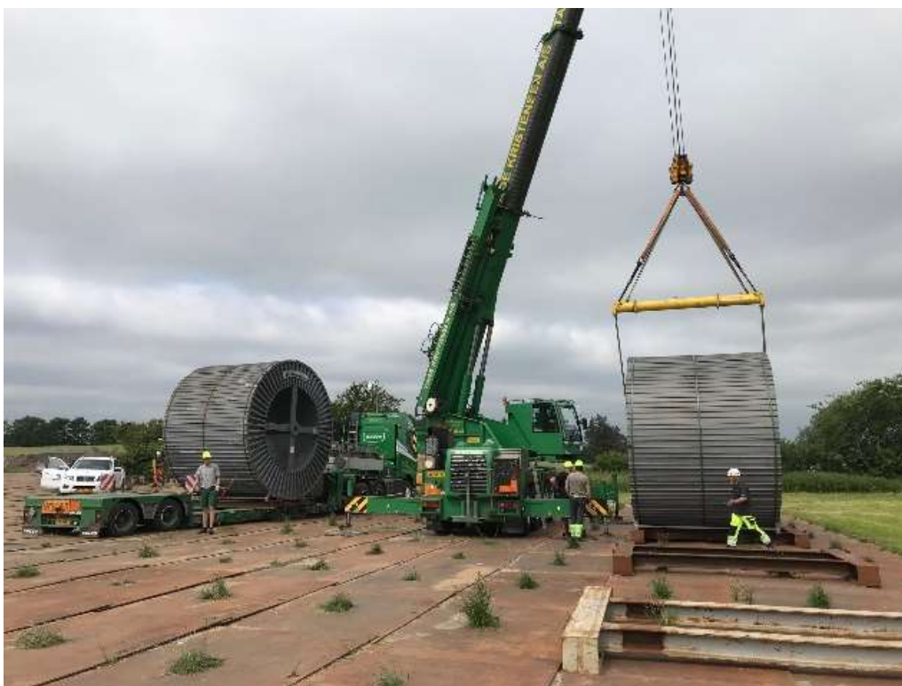
Figur 5.15. Håndtering af kabeltromler på tromleplads
