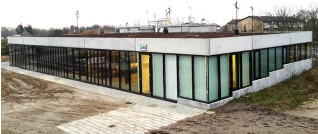
Figur 1 Foto af et tilsvarende renseanlæg på Herlev Hospital. Procestankene ses i baggrunden.
