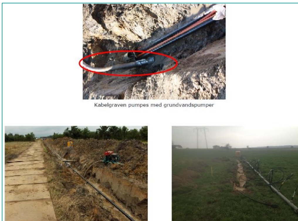
Figur 2-10 Forskellig metoder til at holde kabelgraven tør. På billedet til venstre etableres drænrør, til højre etableres sugespidsanlæg
