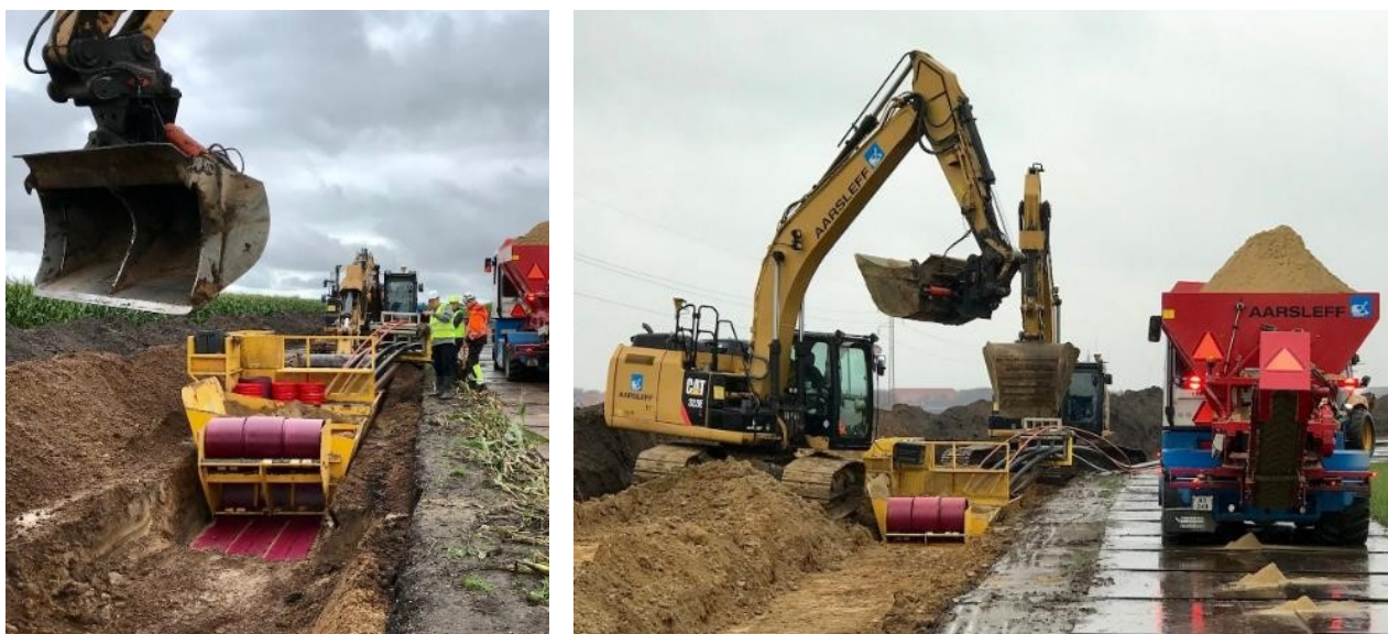
Figur 2-6 Eksempel kabelgravekasse
