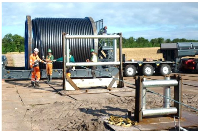
Figur 2-17 Kabeltromle på blokvogn
