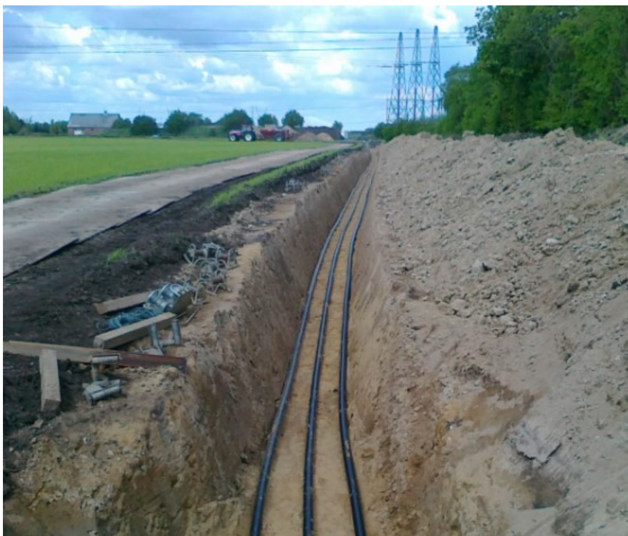
Figur 2-8 Kabelanlæg lagt ud i åben grav
