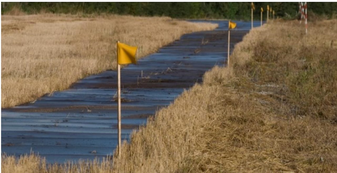
Figur 2-13 adgangsvvej med køreplader
