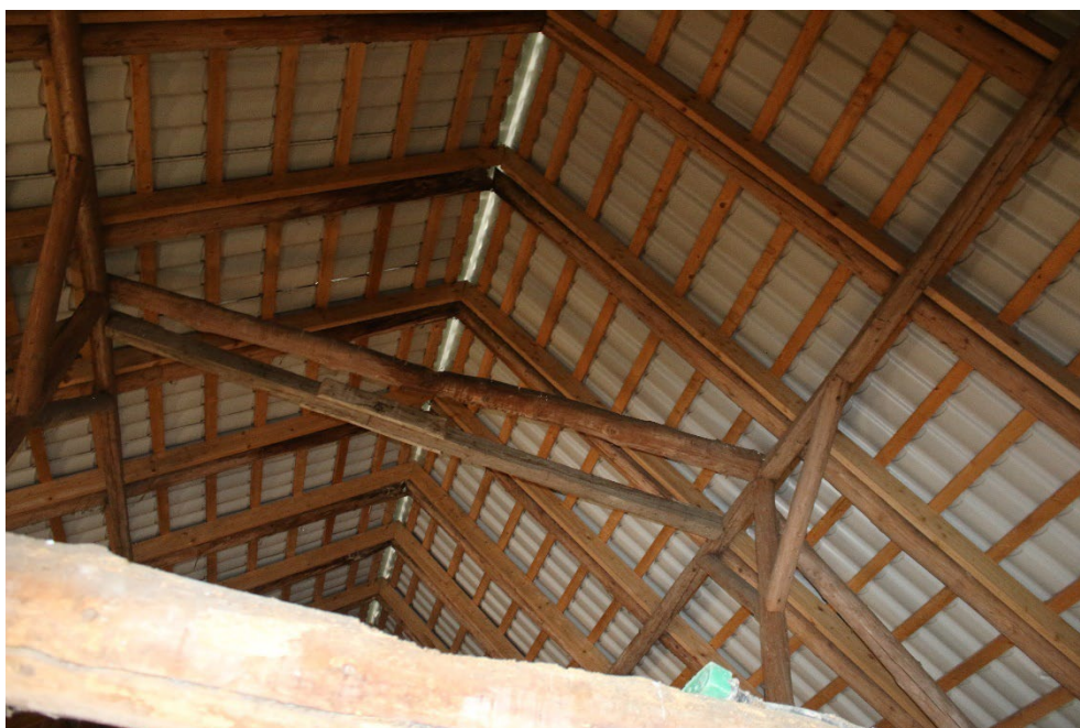
Figur 5-23 Tagkonstruktionen består af blikplader uden undertag eller isolering. Tag-spær og støttende bjælker generelt samlet meget tæt og uden større sprækker, der kan fungere som skjulested for flagermus.
