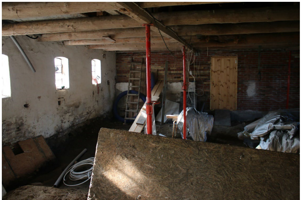
Figur 5-25 Bygningen er under renovering.
