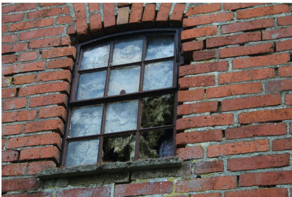
Figur 5-18 På bagsiden er der adskillige huller/sprækker, der giver adgang til bygnings indre.
