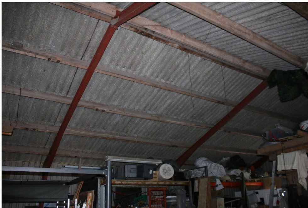
Figur 5-11 Taget udgøres af eternitplader uden undertag eller isolering.
