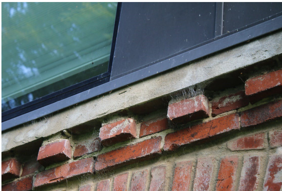
Figur 5-3 Lister slutter tæt til murværk.
