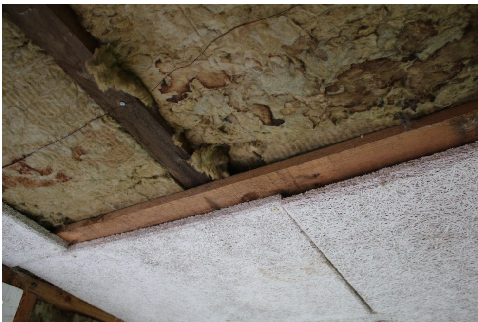
Figur 5-7 Udhæng er uden sprækker, der giver adgang til tagkonstruktion/isolering.
