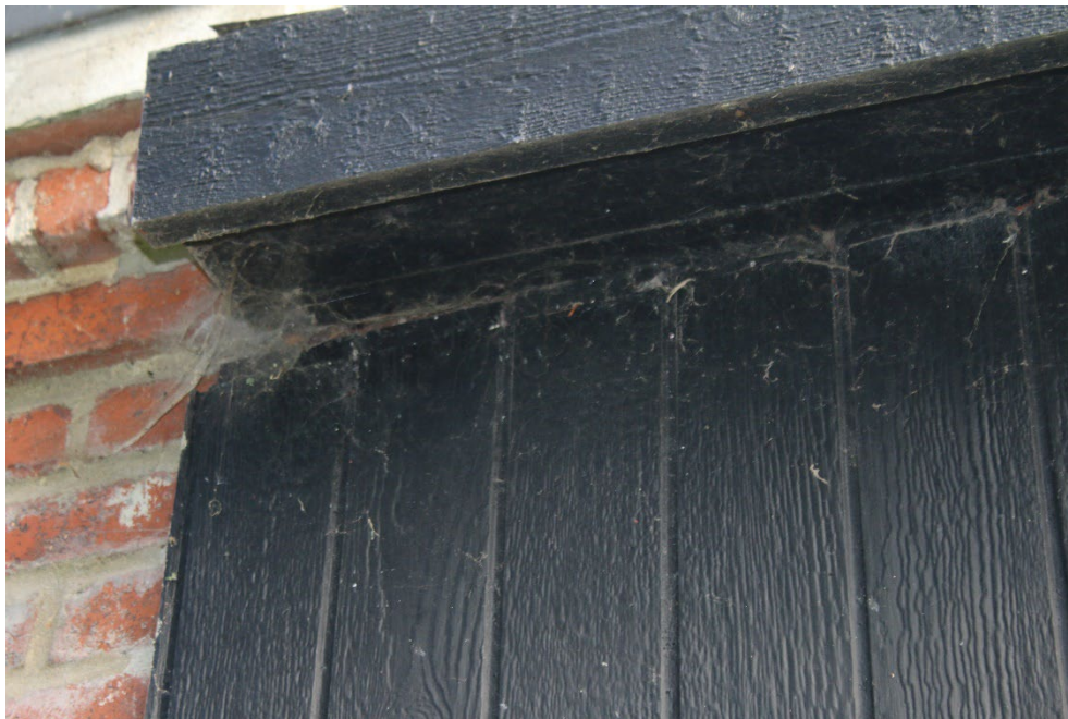
Figur 5-7 Udhæng er uden sprækker, der giver adgang til tagkonstruktion/isolering.
