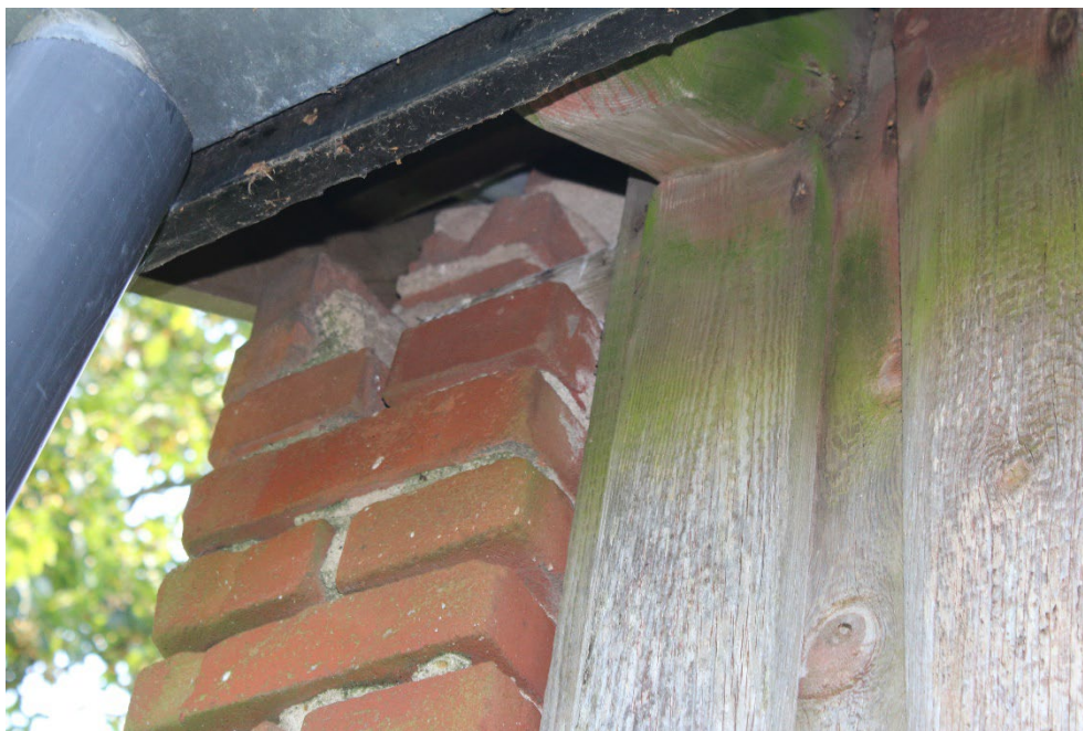
Figur 5-18 På bagsiden er der adskillige huller/sprækker, der giver adgang til bygnings indre.
