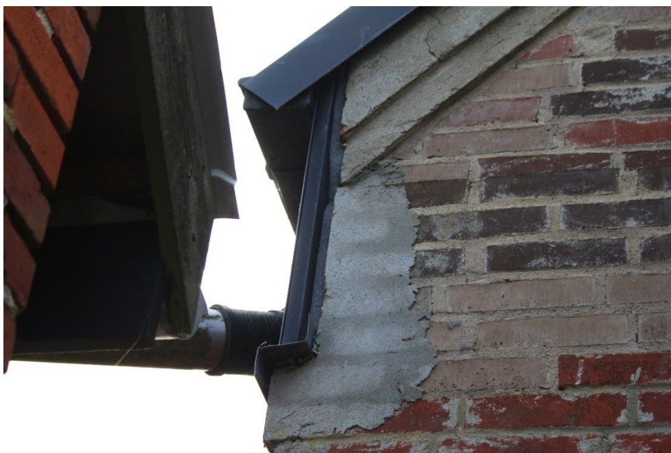
Figur 5-4 Sprækker mellem lister og murværk er lukket med tætningsmasse.
