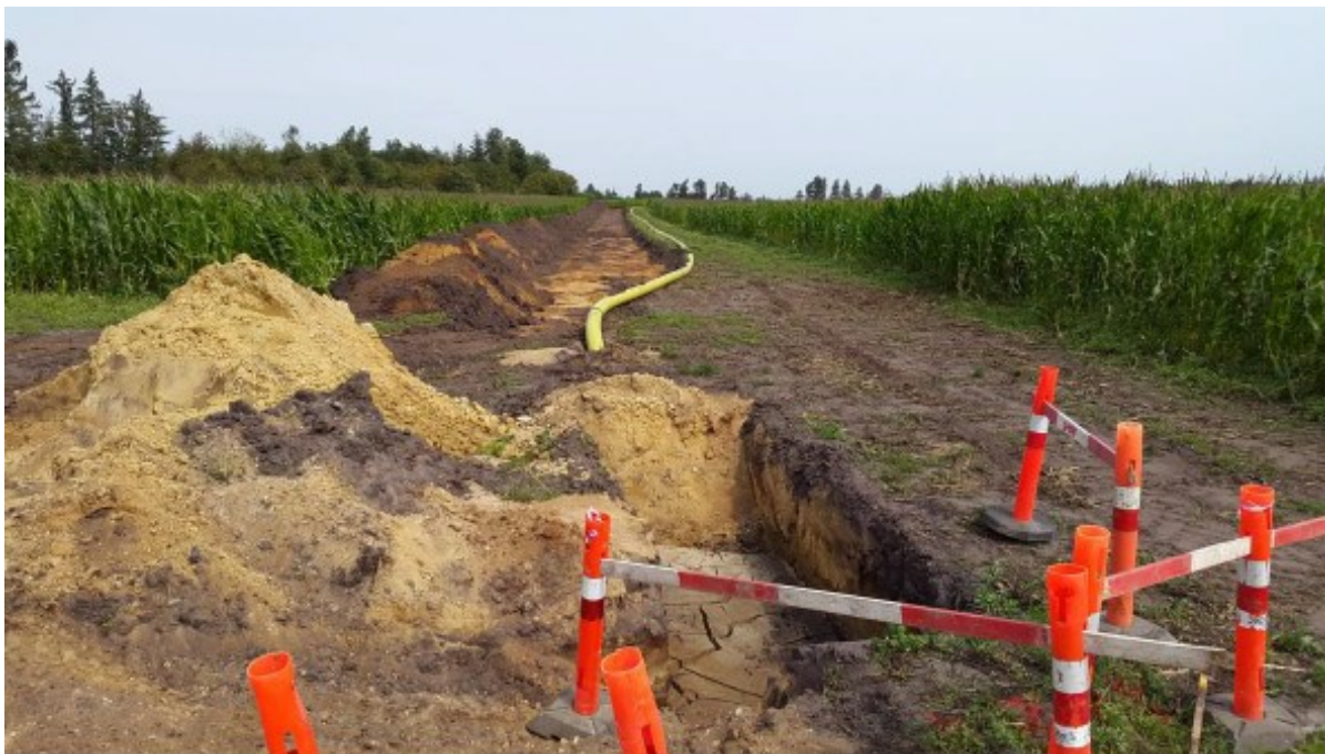
Figur 3: Eksempel på anlæggelse af gasledning i rørgrav. Gasrøret er svejset sammen og muldlaget er afrømmet og ligger klar ved kanten til den kommende rørgrav. Boregrube til underboring ses forrest i billedet. Kilde Evida.
