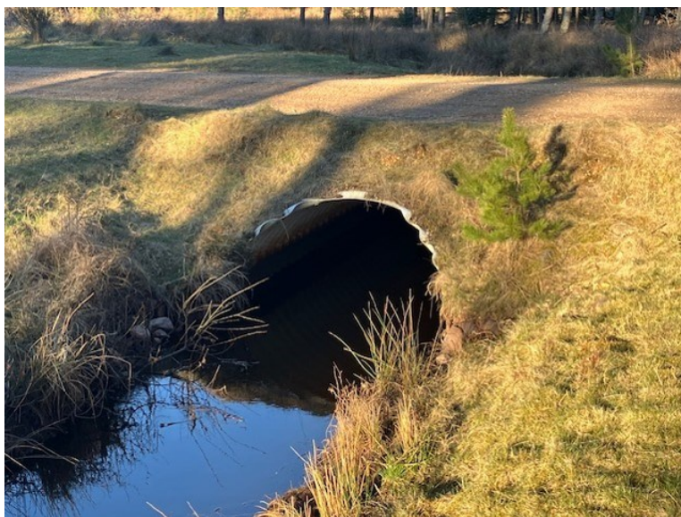
Figur 11: Eksempel på eksisterende grøfteunderføring (Kilde: SKYOKS)
