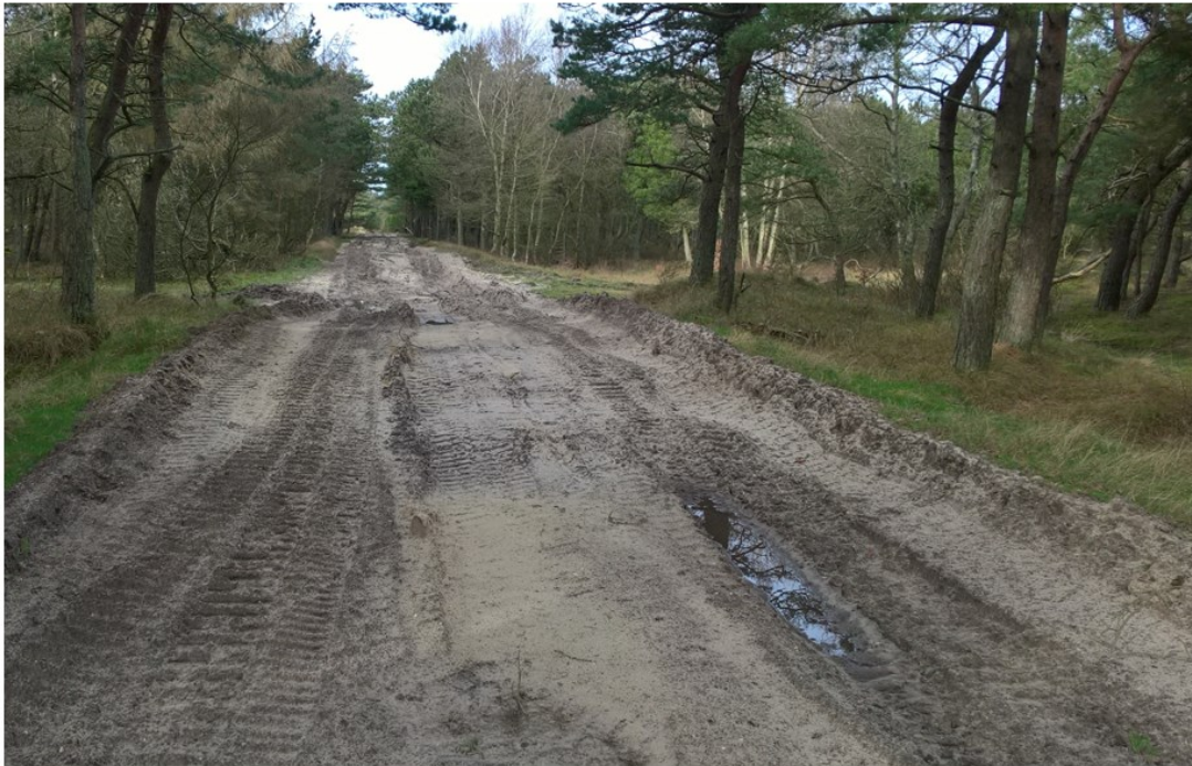
Figur 4: Sandspor i skov. Forud for anlæggelse af spor i skov, vil der blive fældet træer og jorden stubfræses. Sporet anlægges med en bredde på 10 meter og med 2,5 meter rabat på hver side af sporet. Spor og rabat vil efterfølgende i driftsfasen friholdes for træer og buske (Kilde: SKYOKS)
