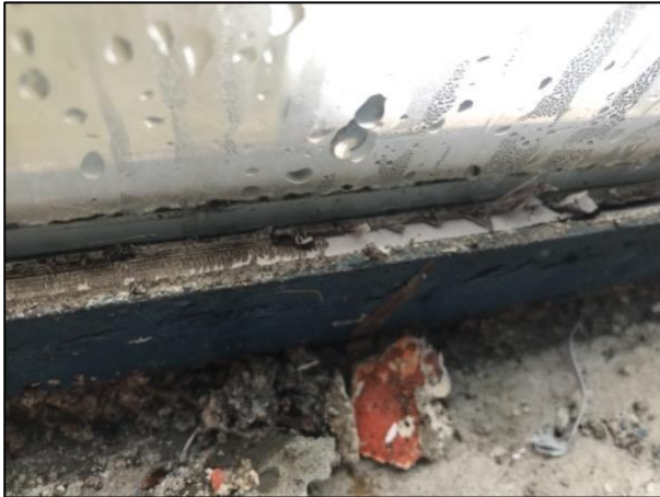
Id: 573, Bygningsdel: Vindue, enkelt-lags, Materiale: Fuge
