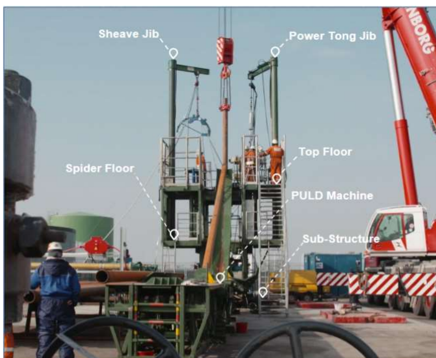
Figur 22 Eksempel på arbejdsplatform til nedlukning af brønde
