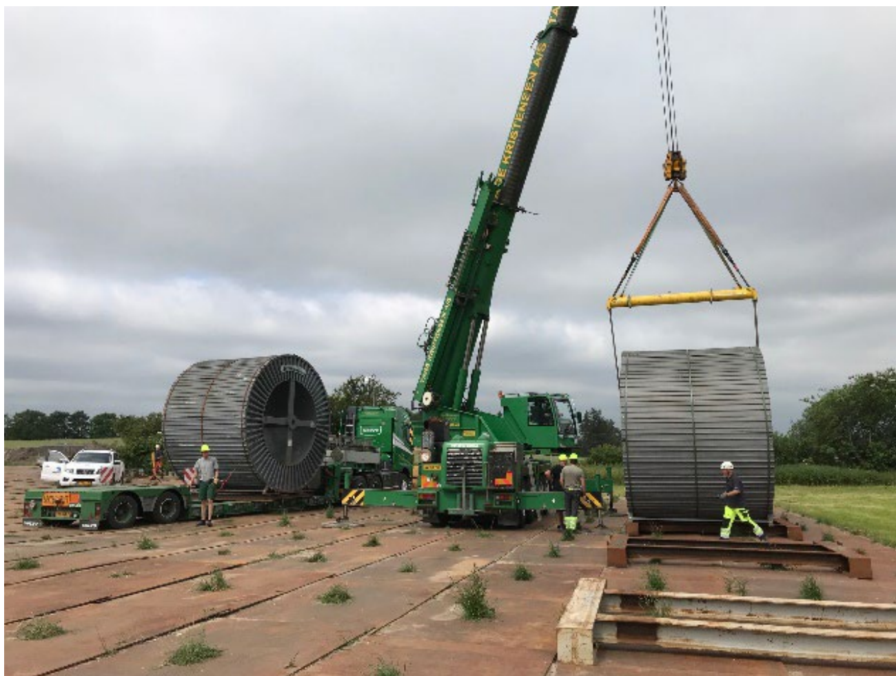
Figur 5-10 Håndtering af kabeltromler på byggeplads
