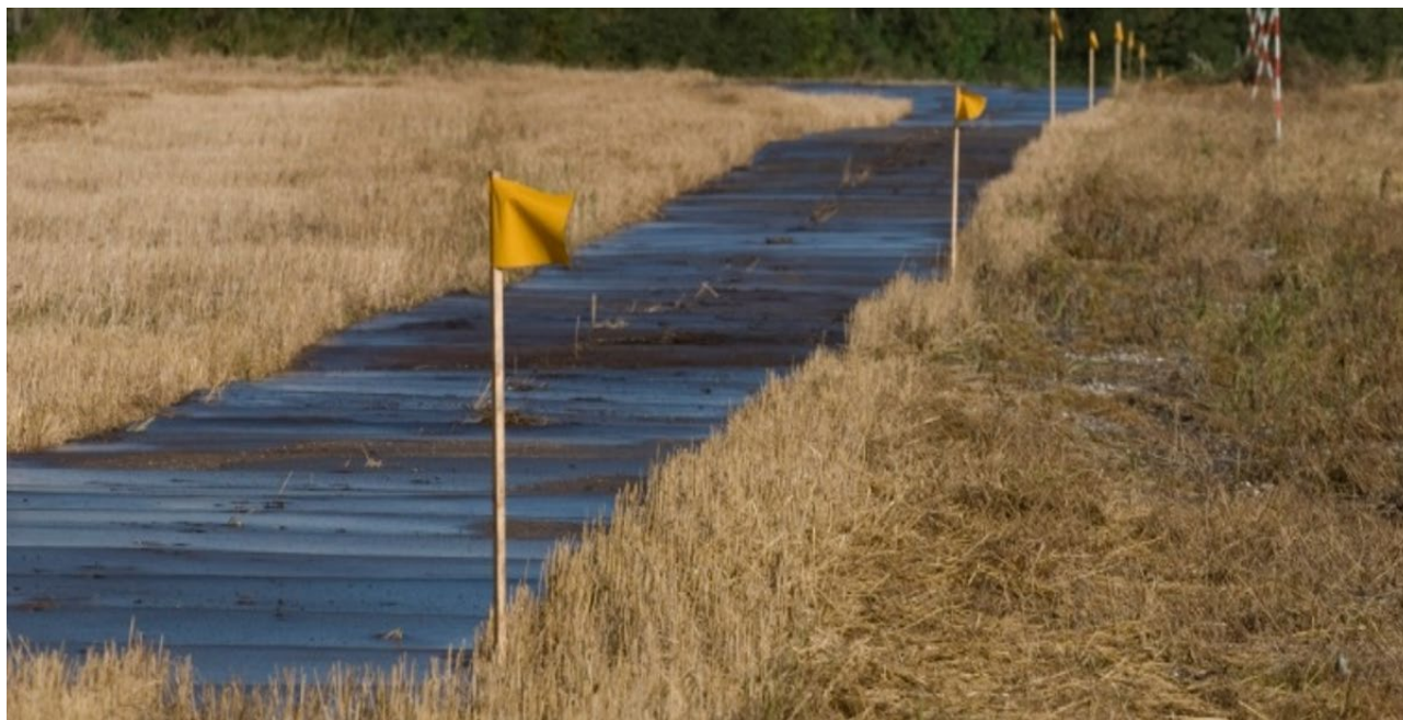
Figur 5-11 adgangsvej med køreplader
