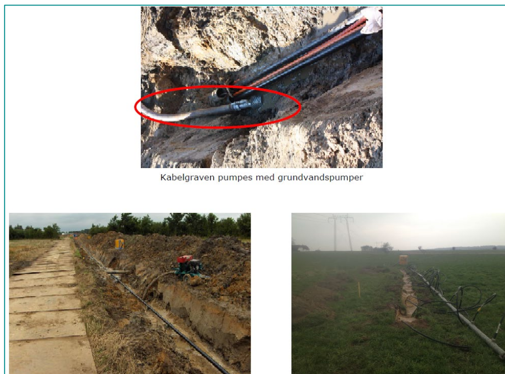
Figur 5-8 Forskellig metoder til at holde kabelgraven tør. På billedet til venstre etableres drænrør, til højre etableres sugespidsanlæg
