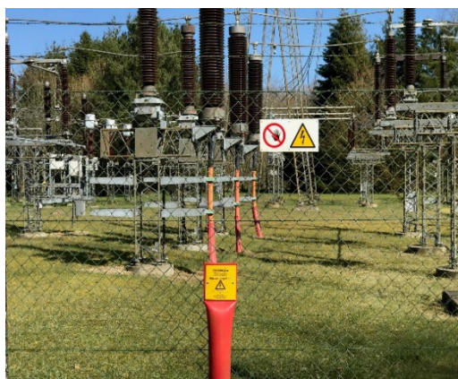
Figur 5-12. Eksempelfoto af markeringspæl og linkboksbrønd
