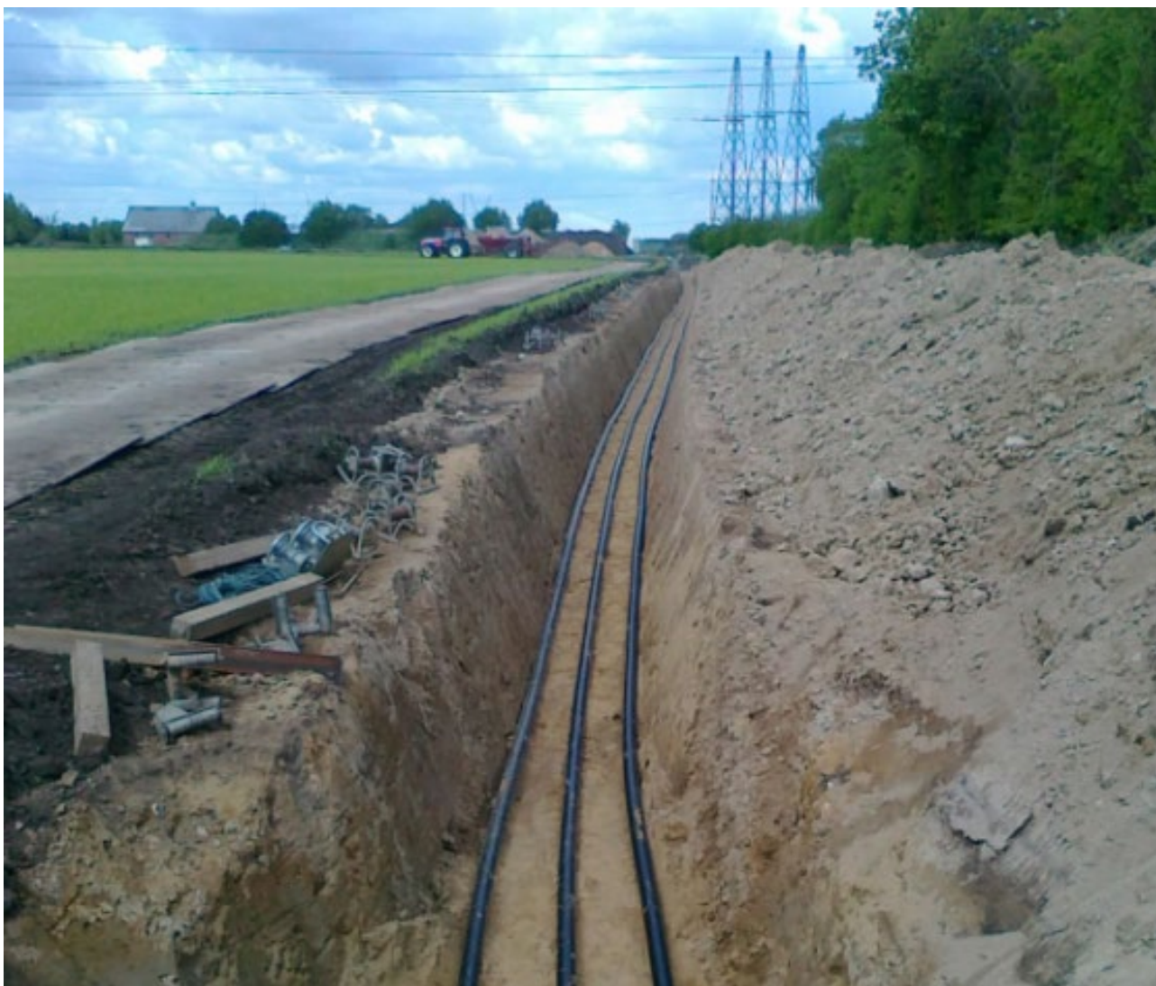
Figur 5-7 Kabelanlæg lagt ud i åben grav
