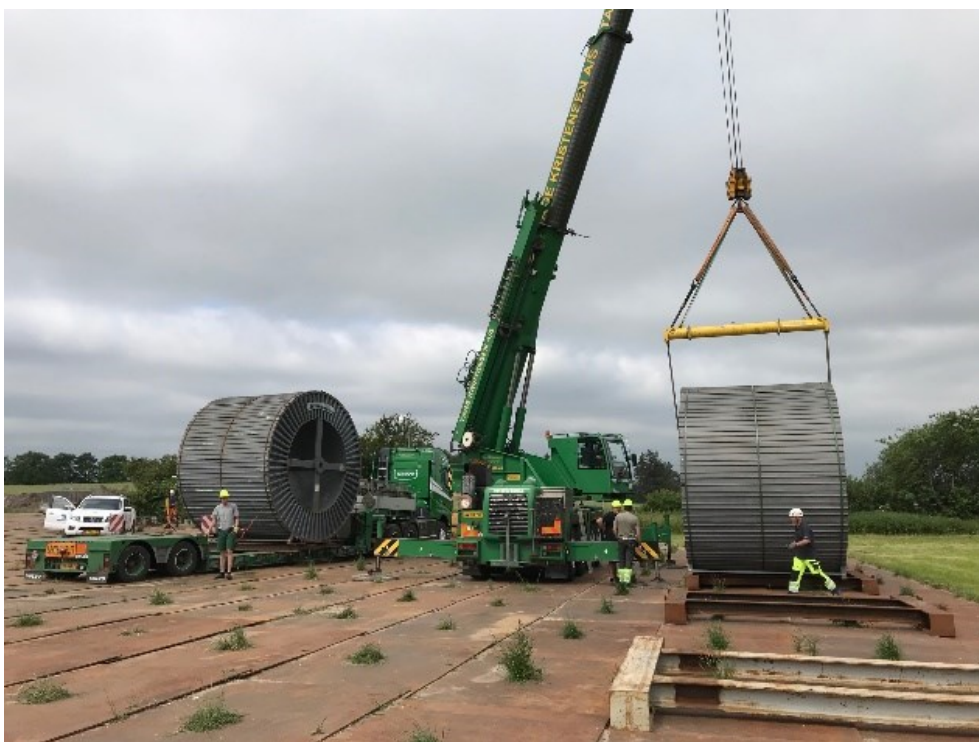
Figur 4.31. Kabeltromler på oplagsplads.
