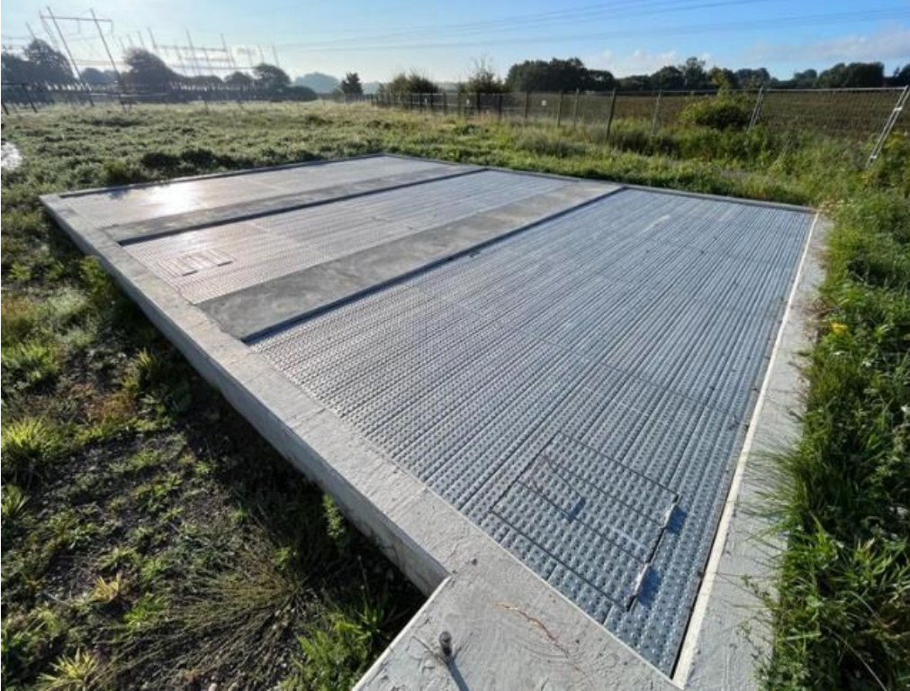
Figur 9.6. Fundament med kar som det ser ud inden der installeres et anlæg.
