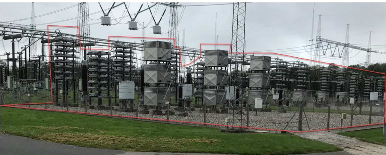
Figur 9.7. Eksempel på filtre. ZF1, ZF2, ZF3 - Vester Hassing. Højde: 8 meter. Fodaftryk 80 x 25 meter.
