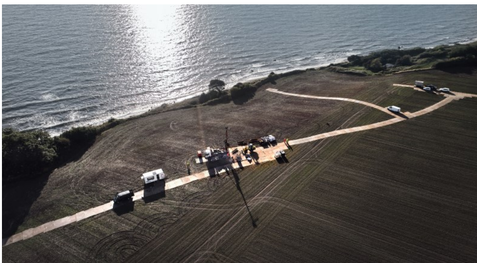
Figur 4.40. Geoteknisk boring til kortlægning af geologien ved Bornholm forud for udførelsen af HDD.
