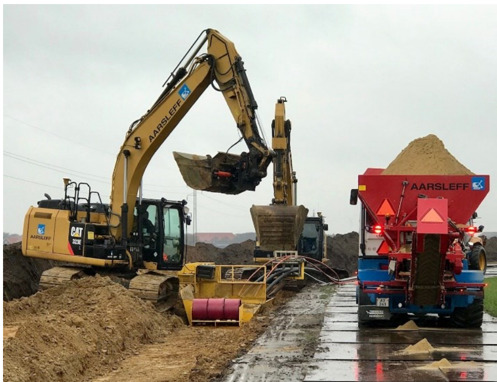
Figur 4.35. Kabellægning med specialfremstillet gravekasse.
