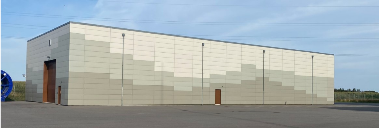
Figur 9.14. Eksempel på et koldt lager. Cobra – Endrup. Højde: 10 meter. Fodaftryk: 20 x 50 meter.
