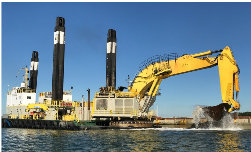
Figur 5.18. Eksempel på en gravemaskine monteret på en jack-up pram, hvor støtteben kan sænkes til havbunden så prammen er stående på havbunden.
