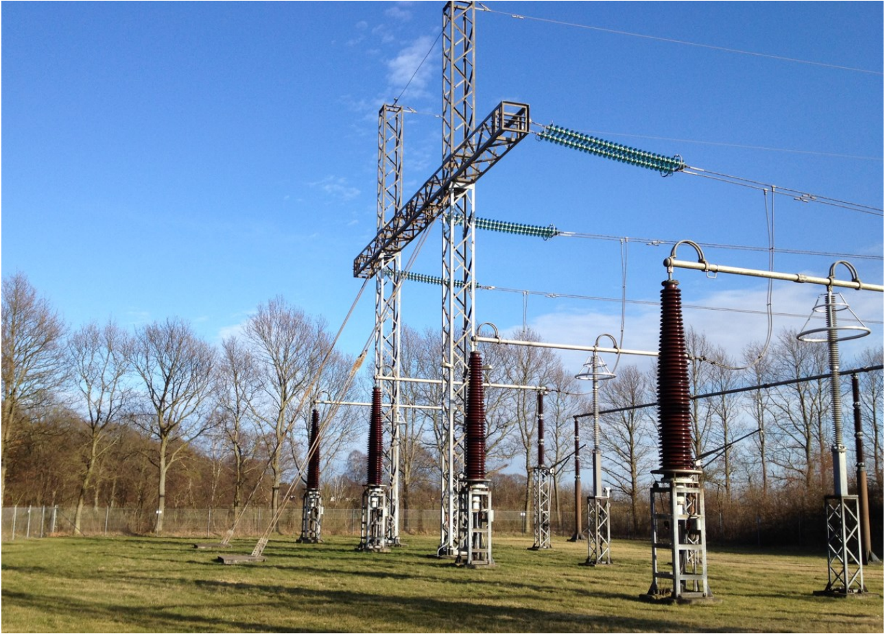
Figur 9.11. Eksempel på overgangsportal med gitterkonstruktion.
