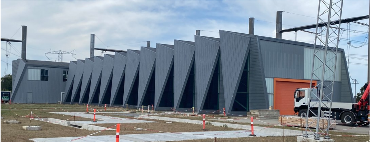
Figur 9.1. Eksempel på en GIS bygning. Højde: 11 meter. Fodaftryk: 1.600 m 2 . Revsing.
