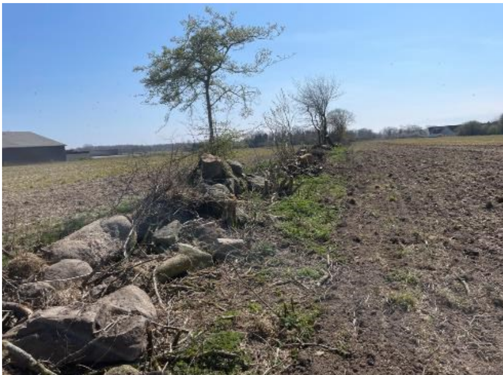
Figur 4.29. Ryddet stendige med enkelte unge træer og buske. Diget er besigtiget som led i det forberedende arbejde til dette projekt.
