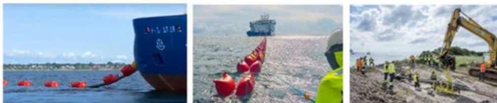
Figur 5.23. Søkablet flyder fra kabelskibet ind i en allerede forberedt rende vha. søkabelflydere.
