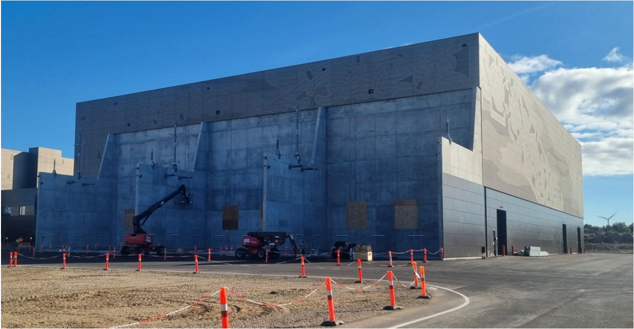
Figur 9.16. Eksempel på en bipol konverterbygning (Én pol) under opførelse. Viking Link – Revsing. Højde: 25 meter. Bemærk at der endnu ikke er installeret konvertertransformere foran konverterbygningen.
