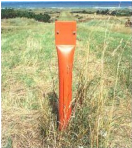
Figur 4.27. Nedgravet kabelanlæg markeres med orange pæl.
