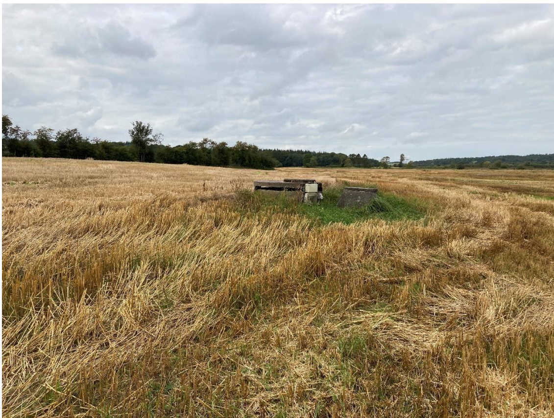
Foto: Pumpebrønd med pumpe.
