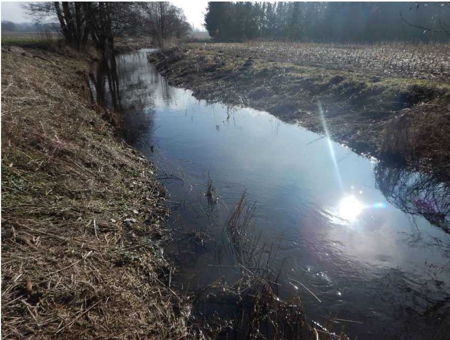
Figur 20 – foto fra Sweco's besigtigelse i 2023 (jf. besigtigelses-notat – Bilag 2.). Sted for underboring af Torpe Kanal, set i opstrømsretning.
