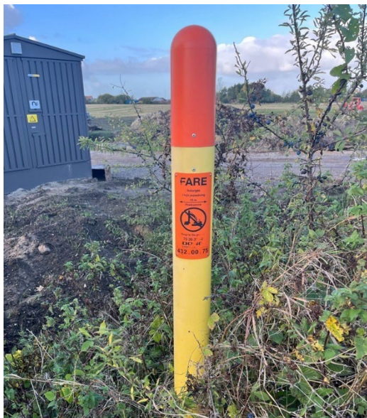
Figur 10: eksempel på mærkestander, der markerer gasrørledningens tilstedeværelse under jordoverfladen
