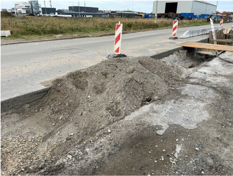
Figur 5 - viser ledningsgrav anlagt med begrænset arbejdsareal
