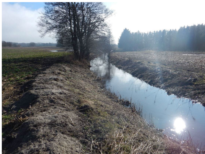
Figur 68 – kortudsnit fra bilag 2_besigtigelsesnotat, som viser krydsningspunktet i Torpe kanal. Foto er taget i 2024, hvor kanalen er ny oprenset
