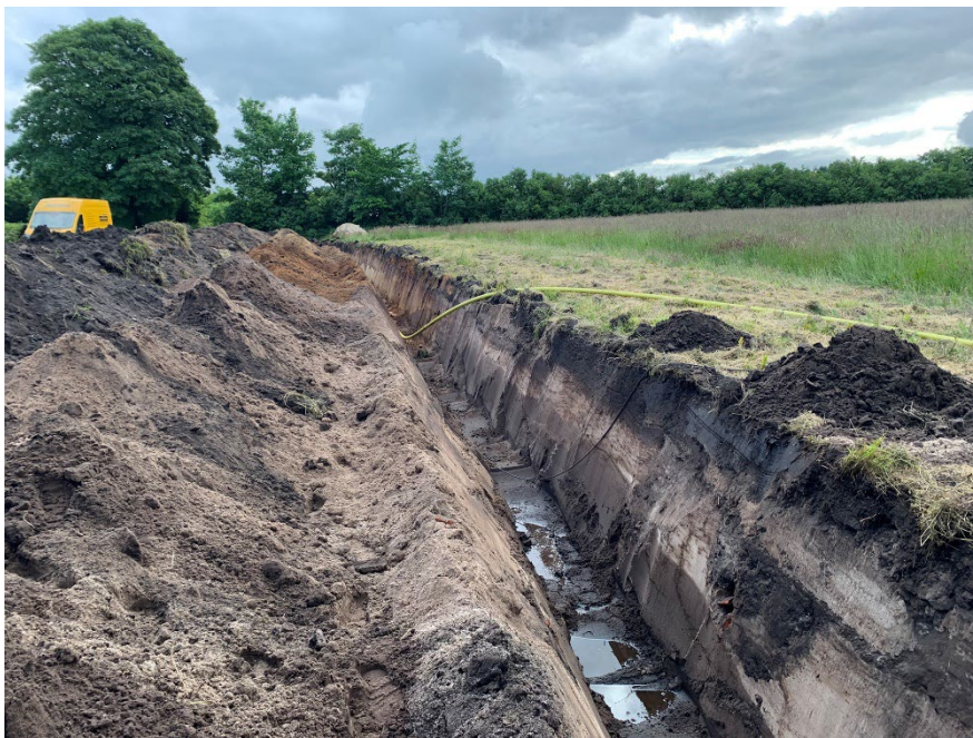
Figur 2: Eksempel på anlæggelse af gasledning i åben ledningsgrav.
