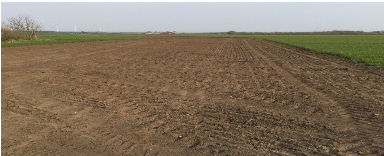
Figur 2-5 Eksempelfoto på udjævnet anlægsbælte
