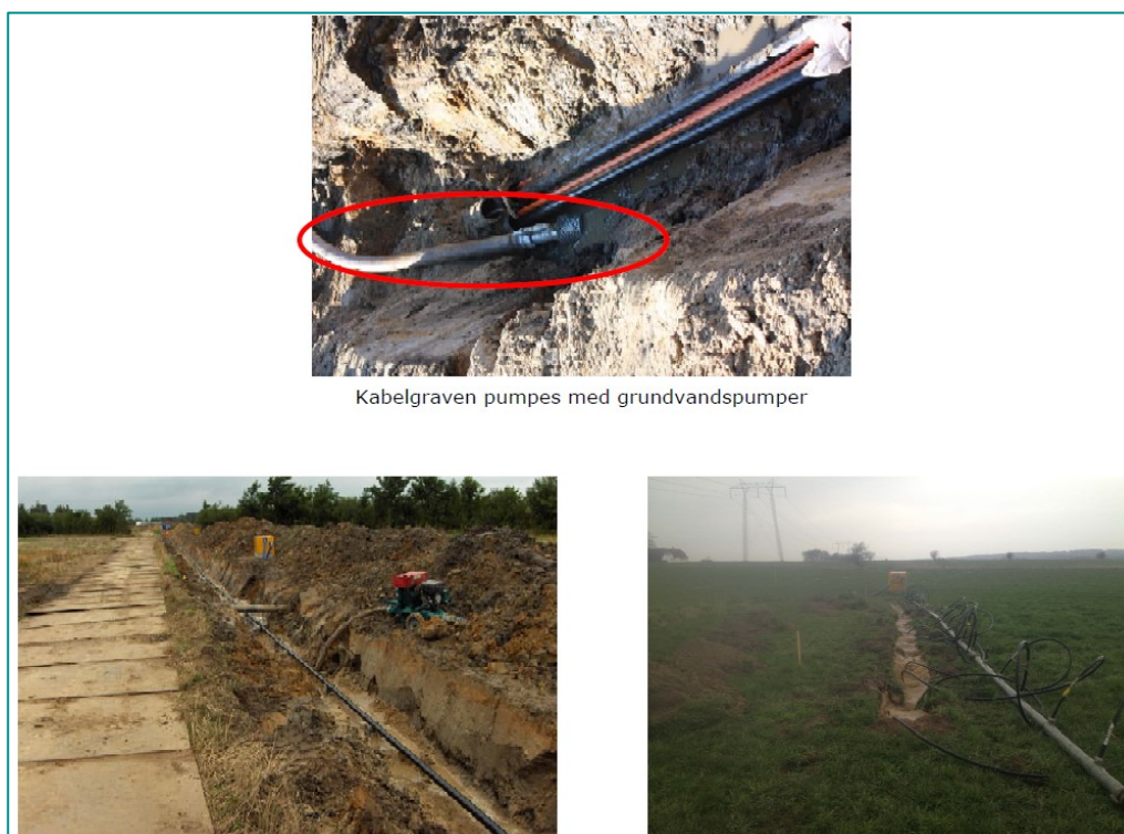
Figur 2-7 Forskellige metoder til at holde kabelgraven tør. På billedet til venstre etableres drænrør, til højre etableres sugespidsanlæg
