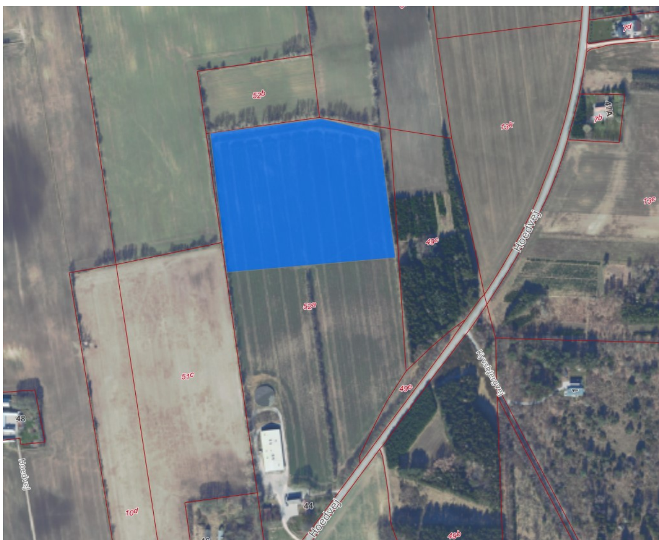
Figur 4-1. Planlægningsområdet (i alt ca. 5 ha) for kompenseringsstationen i Norddjurs Kommune vist med blå farve. Arealet til stationen udgør ca. 2,4 ha (155x155m).
