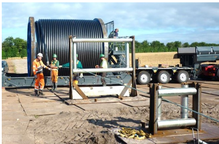
Figur 2-14 Kabeltromle på blokvogn
