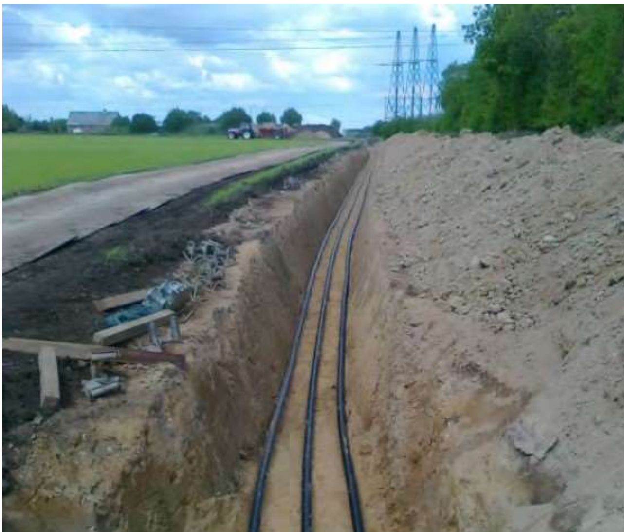
Figur 2-10 Kabelanlæg lagt ud i åben grav
