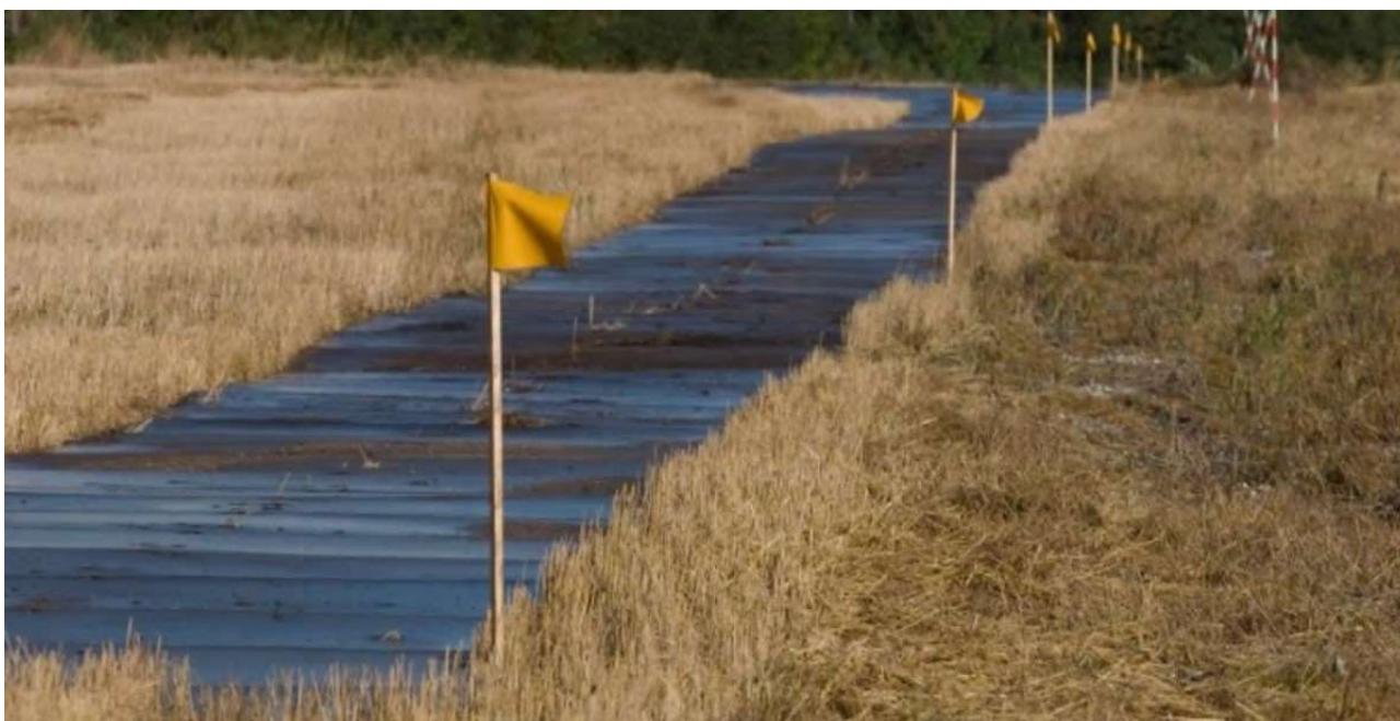
Figur 2-15 adgangsvej med køreplader
