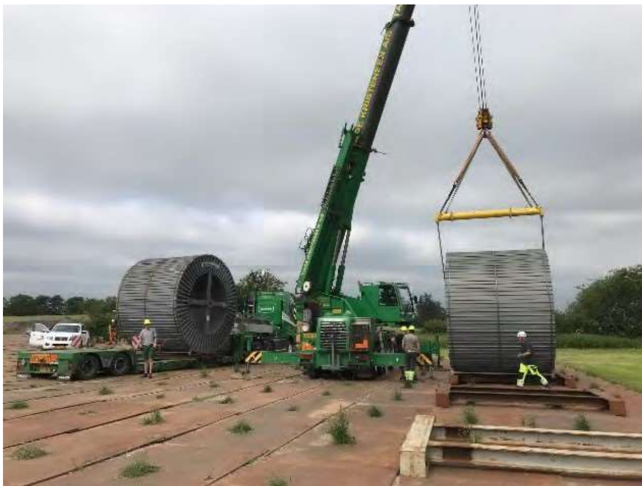
Figur 2-13 Håndtering af kabeltromler på tromleplads
