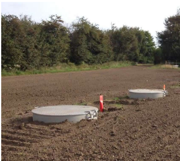
Figur 2-2 Eksempelfoto af linkbokse i terræn
