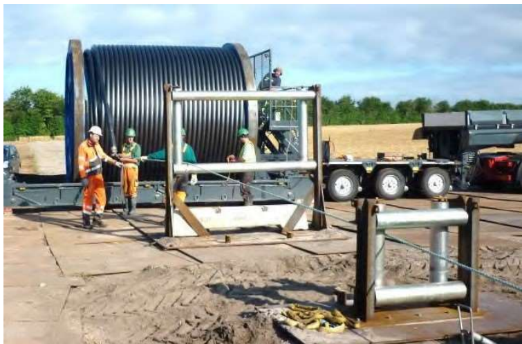
Figur 2-19 Kabeltromle på blokvogn
