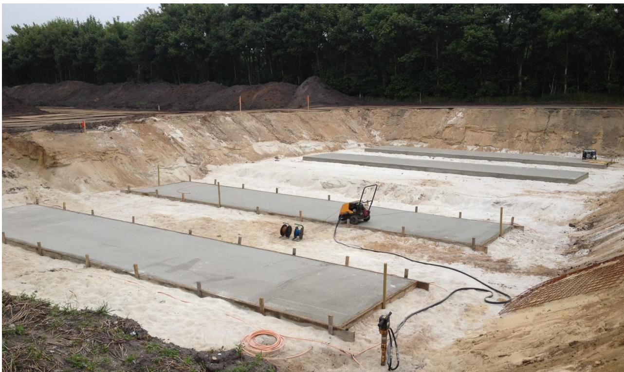
Foto 4-3 Længs kabelstrækningen vil der være behov for at etablere muffegrave hvor kabelenderne samles. Tilstedeværelse i disse områder vil være længere, mens anlægsbæltet ved muffegravene kan være lidt bredere end anlægsbæltet langs kabelgravene.
