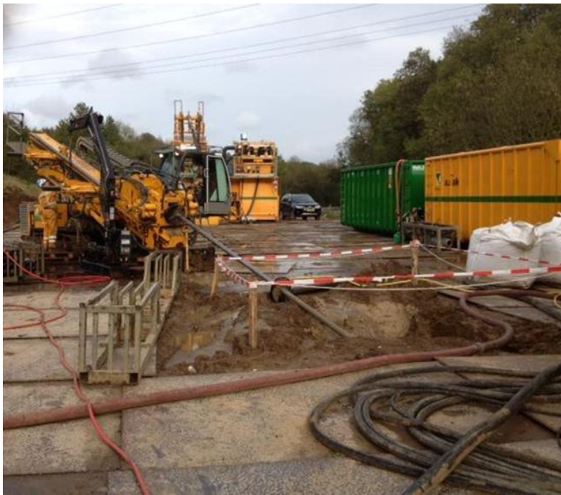
Foto 5-1 Eksempel på arbejdsareal ved lang styret underboring.
