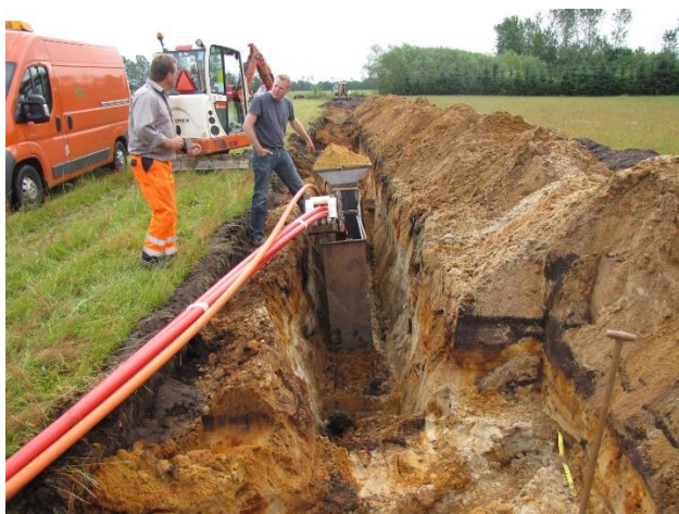
Figur 10-8 Udlægning af 60 kV kabelanlæg i åben grav
