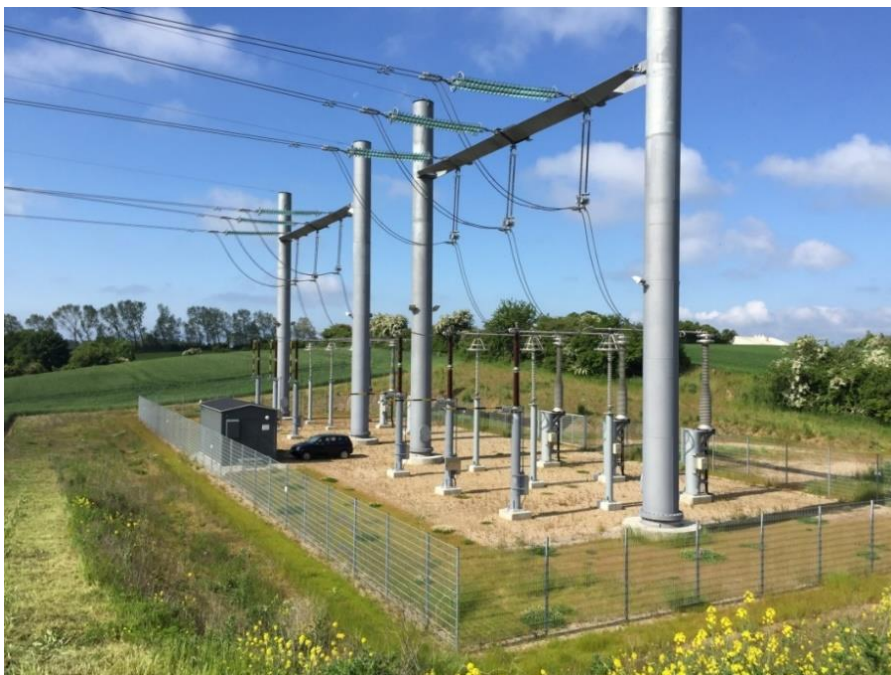
Figur 3-4 Eksempel på endetræksmaster med anvendelse af Eagle master. (Eks fra Fyn)
