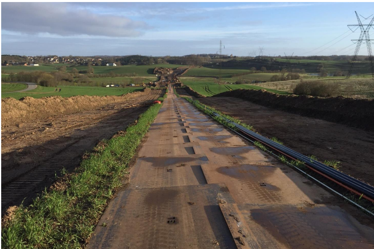
Foto 4-2 Eksempel på et afrømmet arbejdsbælte til dobbelt kabelgrav, lige inden gravning af selve kabelgravene. I dette projekt vil anlægsbæltet være ca. dobbelt så bredt, da der skal laves 4 kabelgrave.
