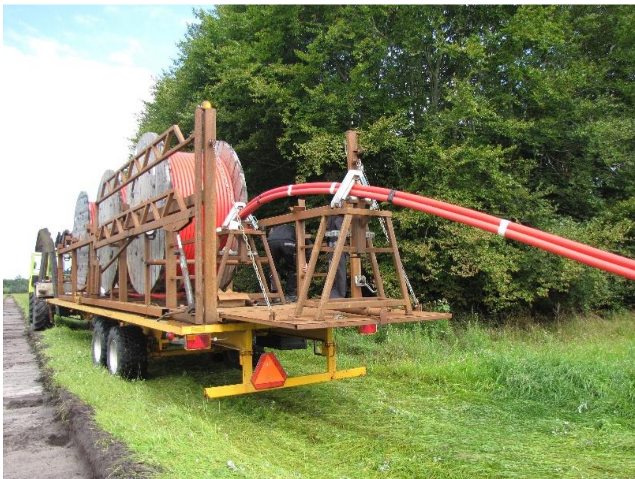
Figur 10-9 Vogn med kabeltromler som benyttes under udlægning af kabler
