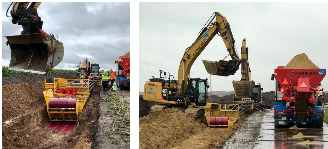
Figur 1-11 Eksempel på anvendelse af gravekasse
