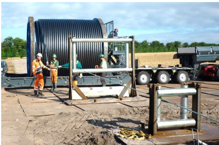
Figur 1-20 Kabeltromle på blokvogn
