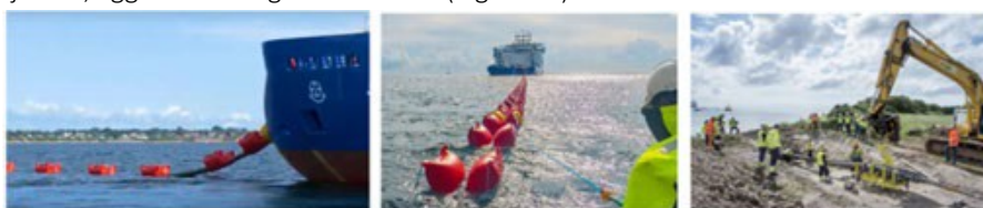
Figur 2-6: Flyd ind af kablet fra kabelskibet med kabelflydere ind i en allerede forberedt rende. (Foto fra NKT-hjemmeside).
