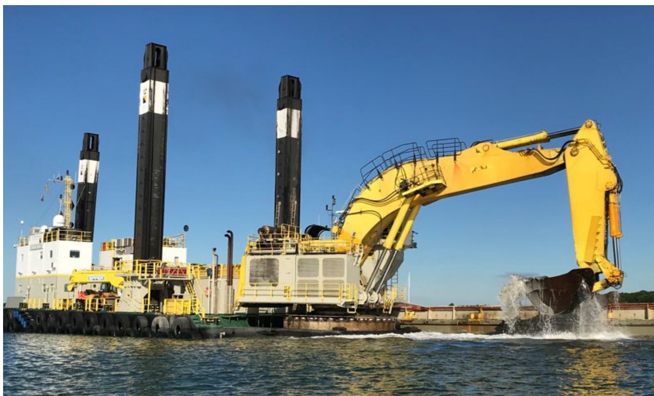
Figur 2-5: Eksempel på en gravemaskine monteret på en pram. Billedet er fra Baltic Pipe.
