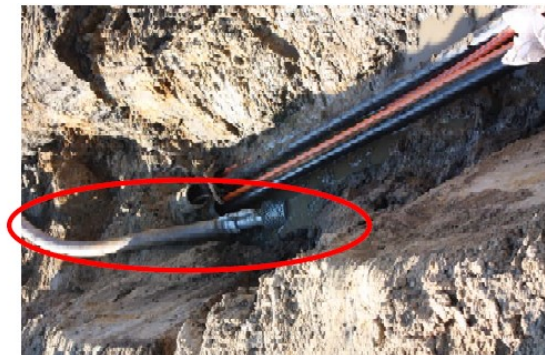
Kabelgraven pumpes med grundvandspumper
