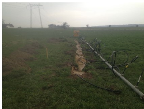
Figur 1-14 Forskellige metoder til at holde kabelgraven tør. På billedet til venstre etableres drænrør, til højre etableres sugespidsanlæg
