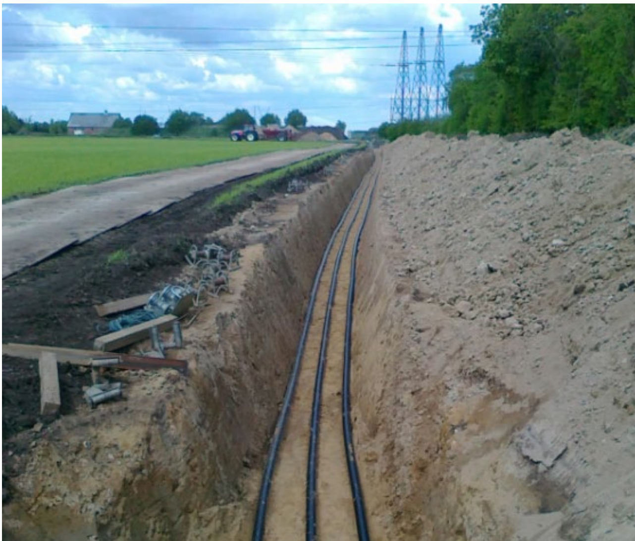
Figur 2–9 Eksempelfoto af kabelanlæg lagt ud i åben grav.
