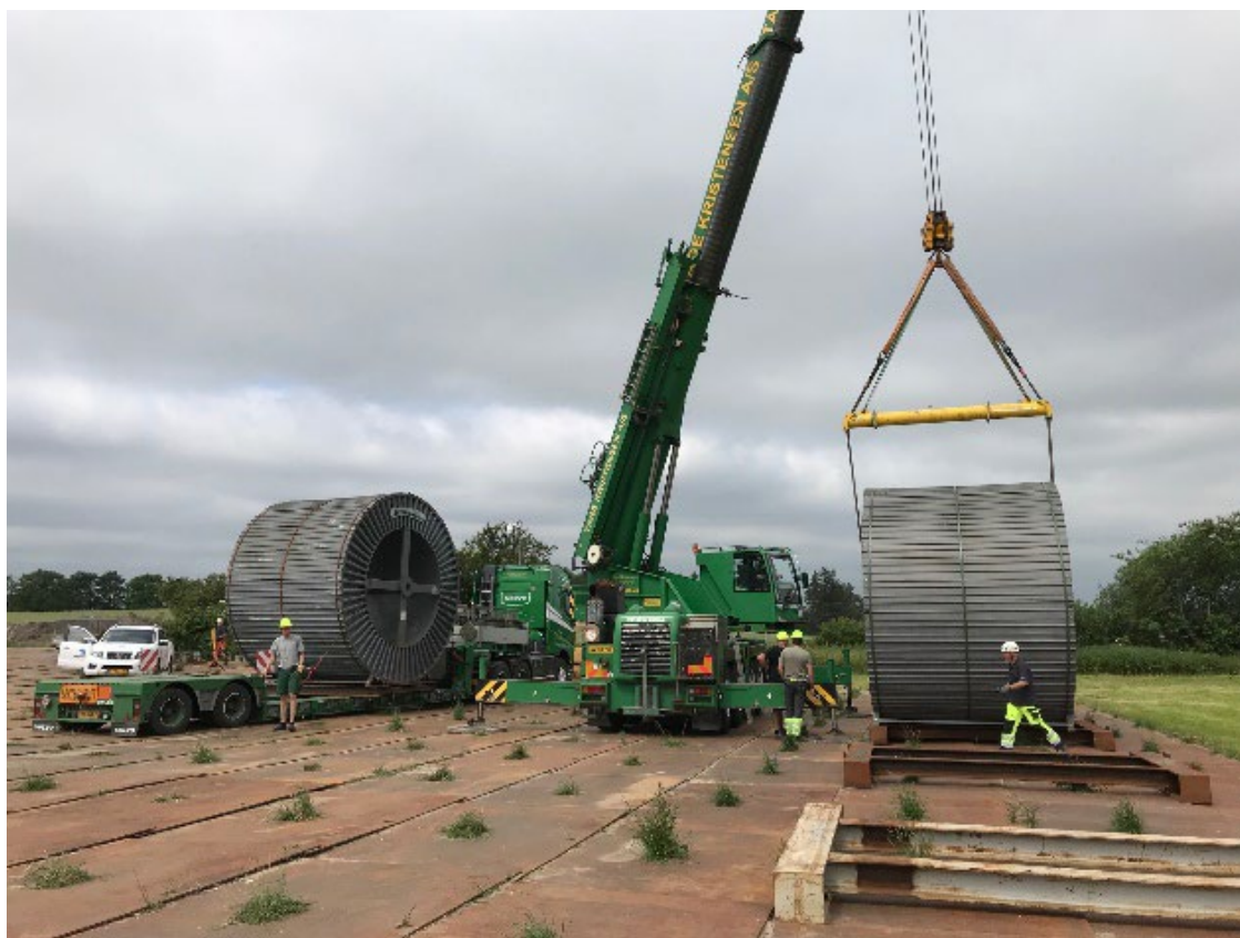
Figur 2–11 Eksempelfoto af håndtering af kabeltromler.
