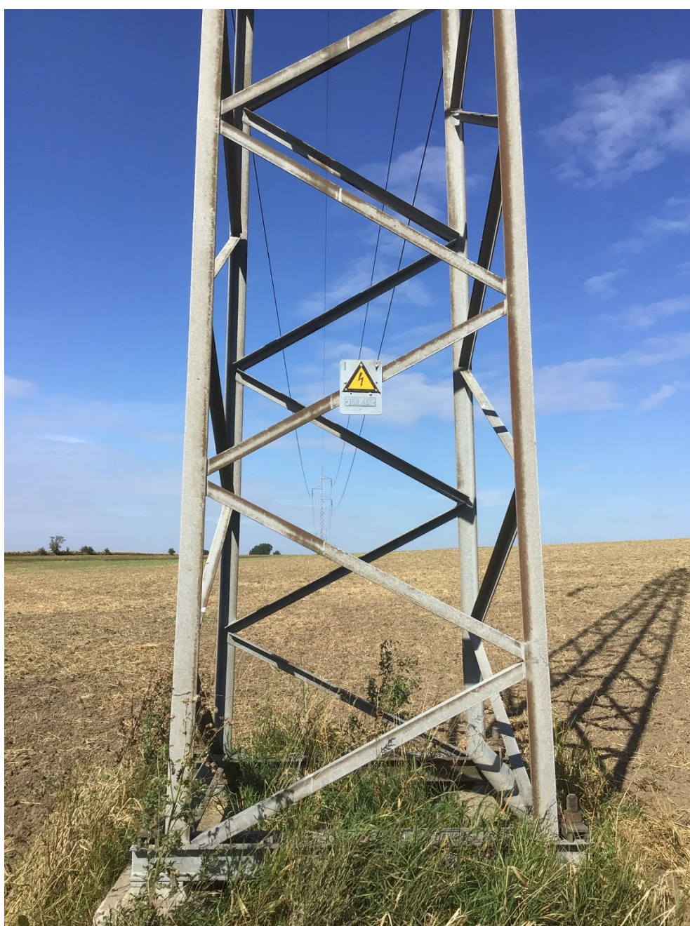
Figur 7–1 Luftledningssystemet der fjernes. Mast nr. 46.
