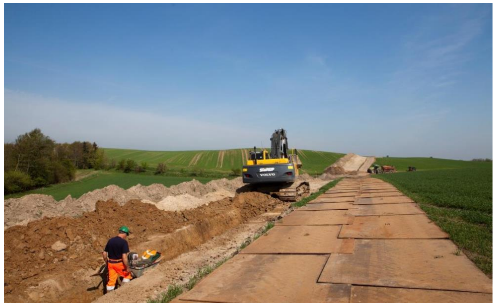
Figur 4-7: Eksempel på arbejdsbælte med afrømet rå- og muldjord samt køreplader. På billedet ses et kabeltracé med ét kabelanlæg.
