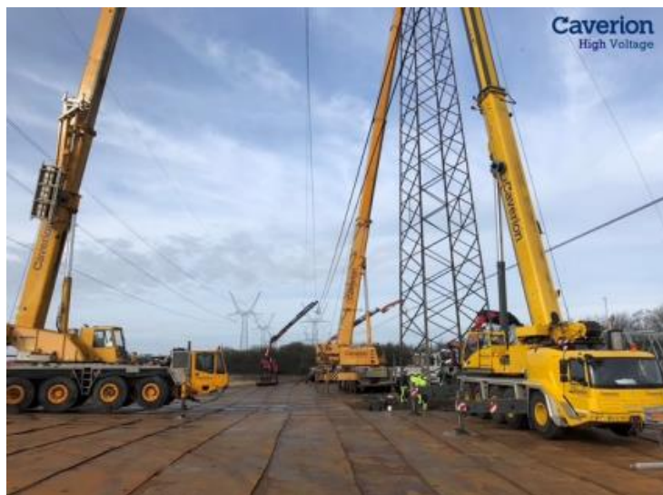
Figur 2. Eksempel på standard-arbejdsareal. Til venstre ses kranen, der holder lederen oppe, forrest hovedkranen, som løfter masten og bagerst kranen med lift til personale. Desuden benyttes en fjerde kran kaldet bundkranen (ses ikke af fotoet), som placeres i større afstand fra masten og bruges til at tage fat i bunden af masten når den er i luften, så masten kan lægges forsigtigt ned.
