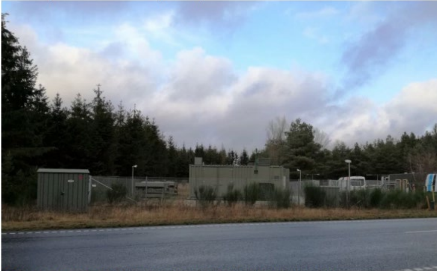
Billede 4 – Eksempel på eksisterende anlæg med samme komponenter
