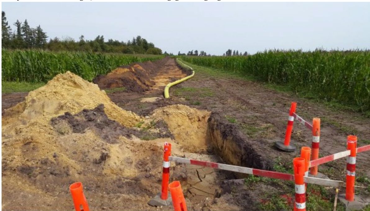
Figur 3: Eksempel på anlæggelse af gasledning i rørgrav. Gasrøret er svejset sammen og muldlaget er afgrømmet og ligger klar ved kanten til den kommende rørgrav. Boregrube til underboring ses forrest i billedet. Kilde Evida.
