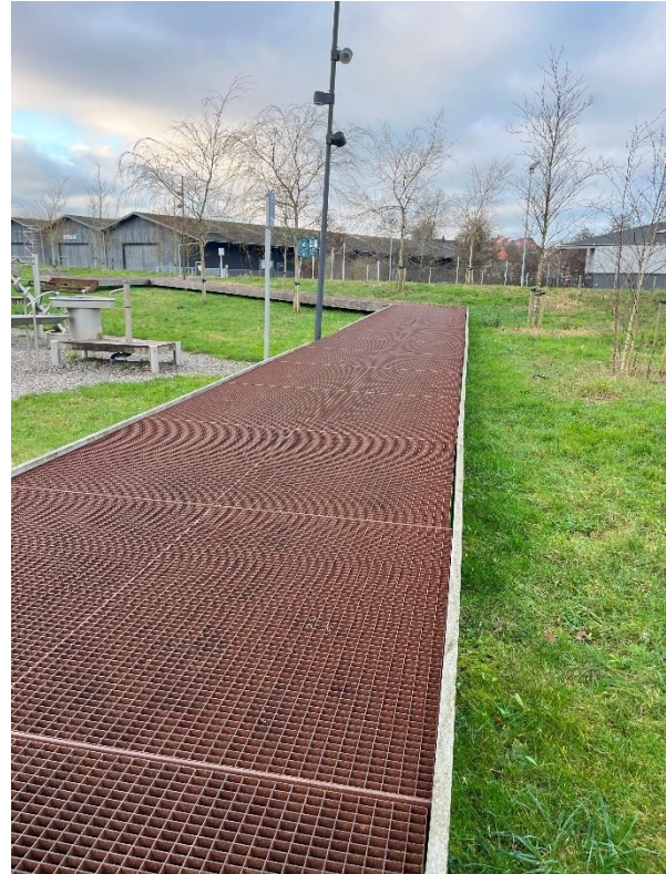
Figur 6: eksempel på boardwalk med overflade af cor-tenstålriste. Foto: Lasse Filsø, Thisted kommune
