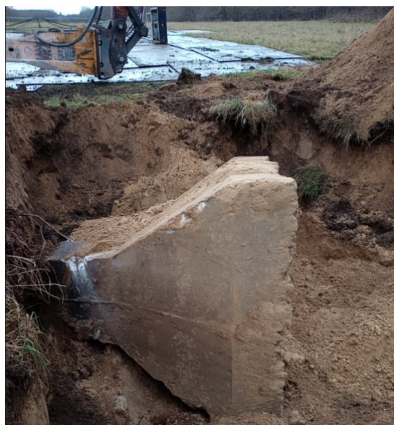
Billede 4.5. Billeder af fundamenter ved opgravning fra et tilsvarende projekt med nedtagning af luftledning.
