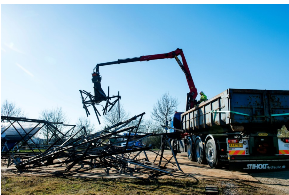
Figur 4.2. En demonteret mast køres til genanvendelse
