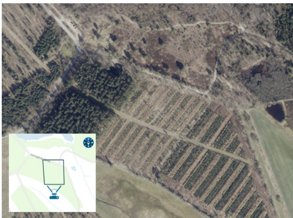
Figur 3.2 Luftfoto af kabelstrækningen gennem fredskov øst for Karlsgårde højspændingsstation.
