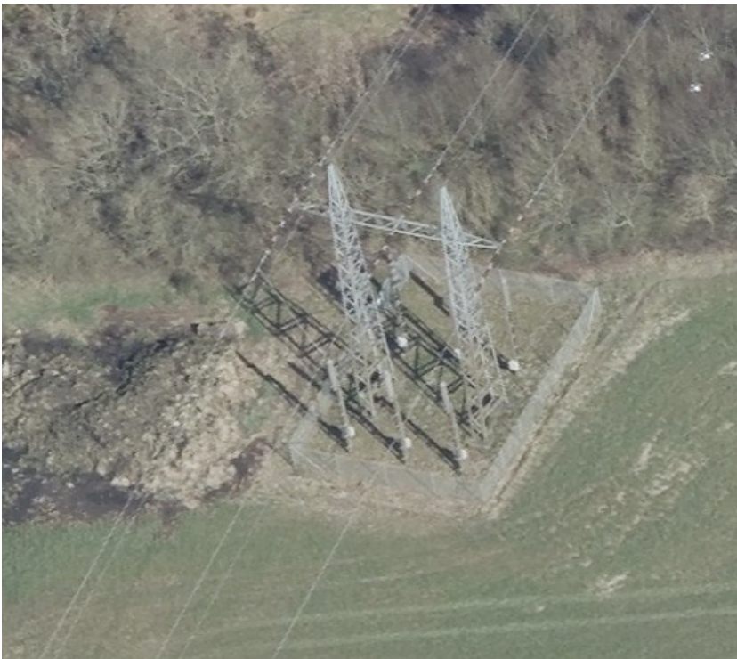
Billede 2.3 Skråfoto af Bredmose Kabelstation
