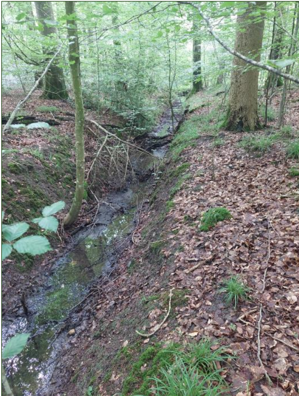
Figur 3.4 H1. Et forårsbillede ned gennem grøften, hvor bunden hæves til ca. 40 cm under terræn.
