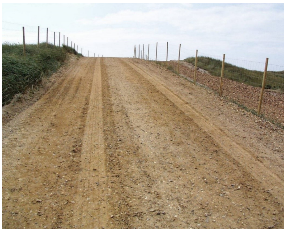
Foto 5. Den stabiliserede adgangsvej på 'toppen' af vejen, fra Syd Arne projektet i 1998.
