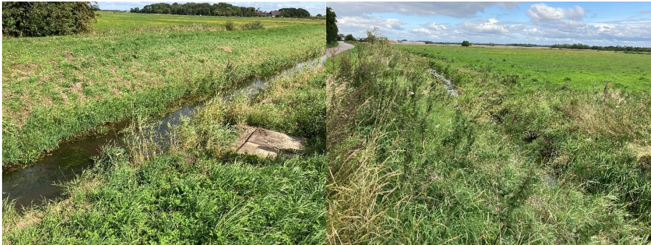
Figur 1.3: Billede på venstre viser afvandingskanal E ved underføring ved Hjerpstedvej og billede på højre viser Sejersbæk Visby langs Trøjborgvej nord for Trøjborg Ruin (26. august 2021).
