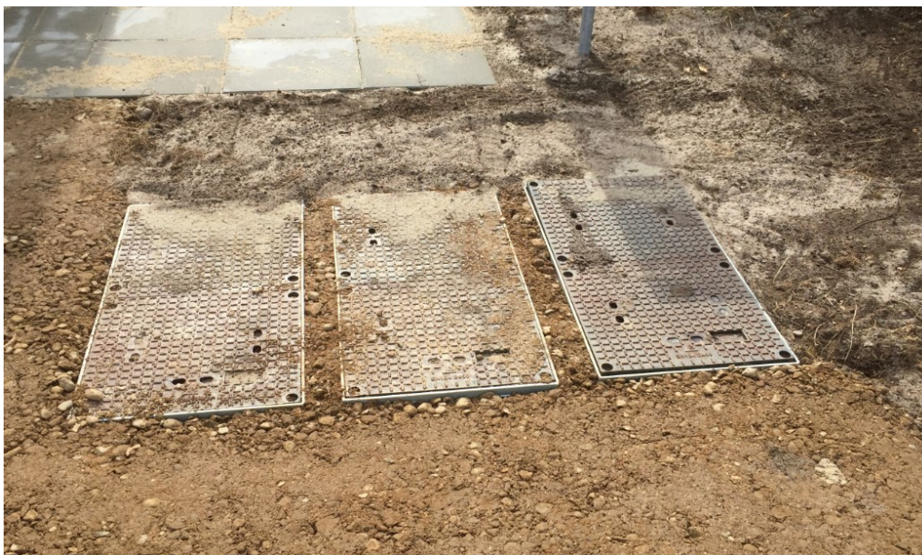
Figur 4-4 Eksempel på 3 stk. fiberbrønde i færdigt terræn
