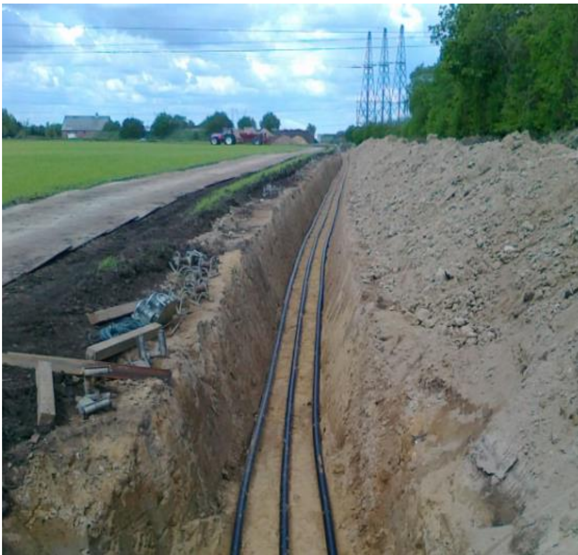
Figur 7 Kabelanlæg lagt ud i åben grav
