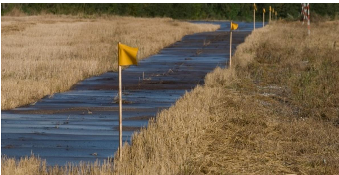
Figur 11 Køreplader lagt ud til adgangsvej
