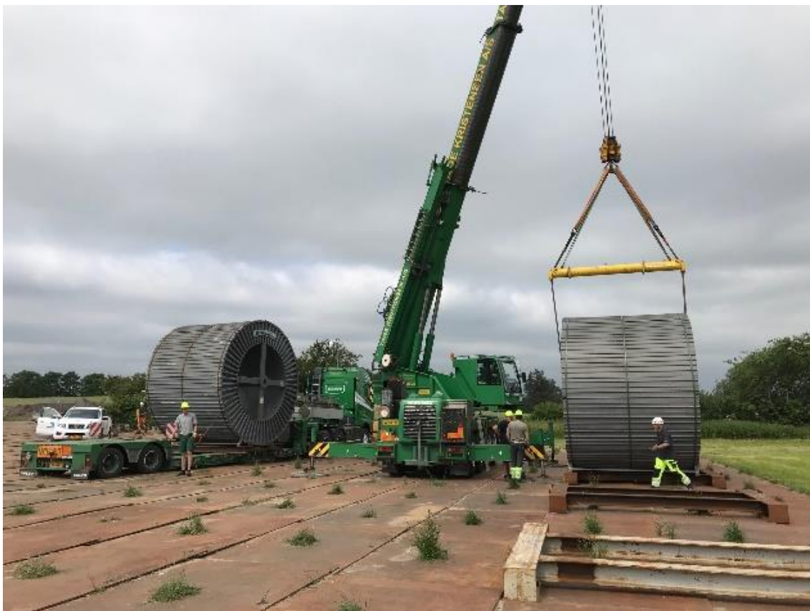
Figur 9 Håndtering af kabeltromler på tromleplads
