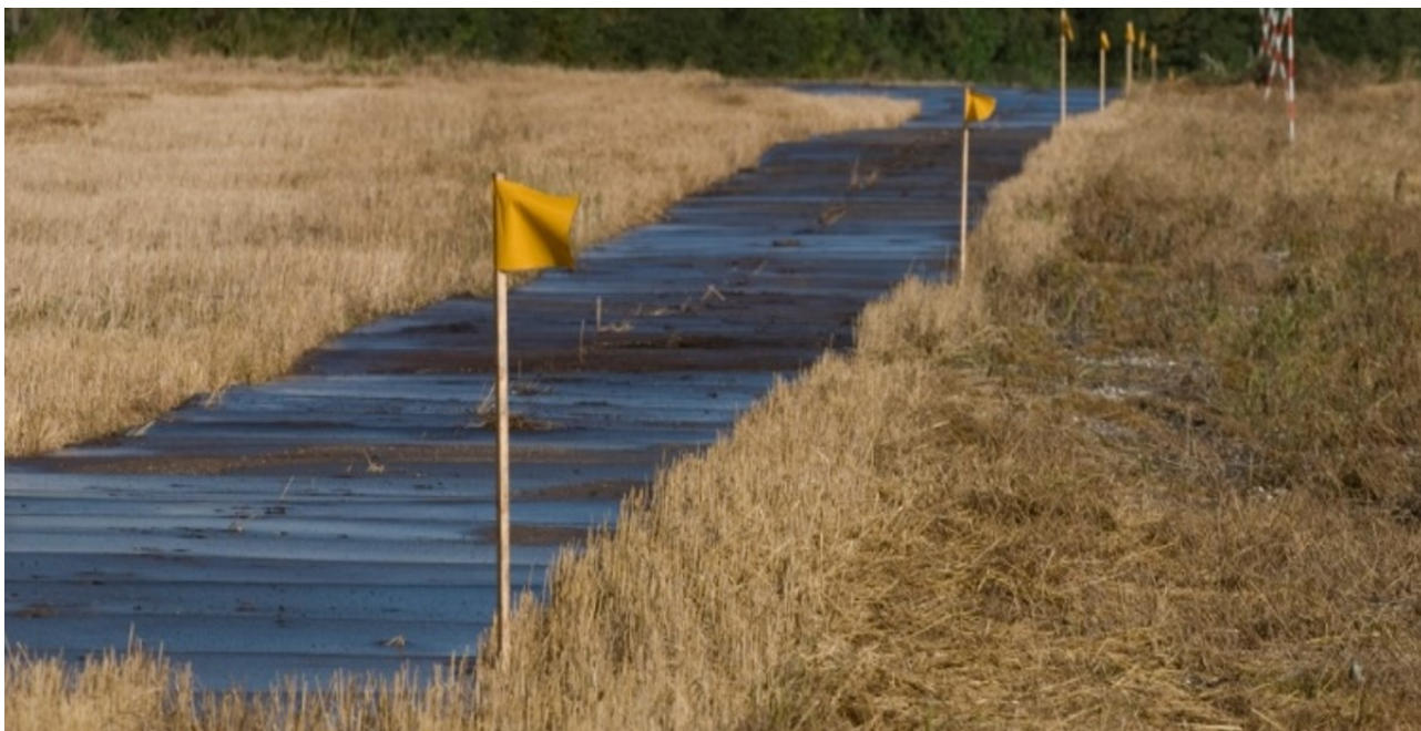
Figur 2-11 adgangsvej med køreplader
