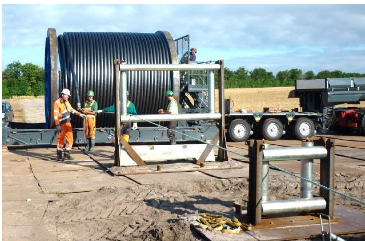
Figur 2-15 Kabeltromle på blokvogn
