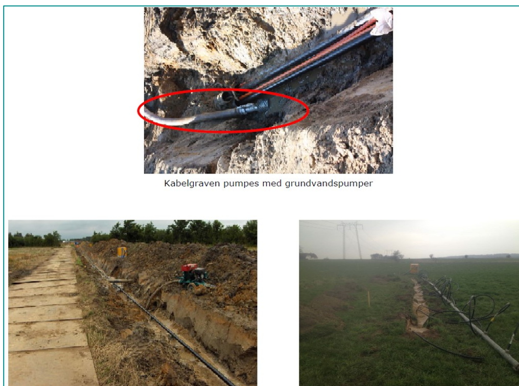
Figur 2-8 Forskellige metoder til at holde kabelgraven tør. På billedet til venstre etableres drænrør, til højre etableres sugespidsanlæg
