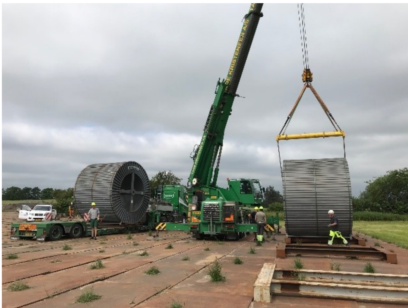
Figur 2-9 Håndtering af kabeltromler på tromleplads
