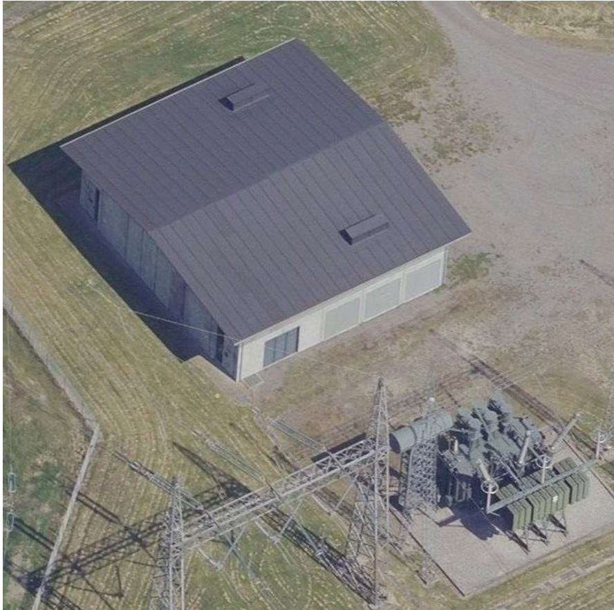
Figur 1.5. Eksempel på en bygning indeholdende et 220 kV-gasisoleret kompakt indendørs koblingsanlæg (GIS).
