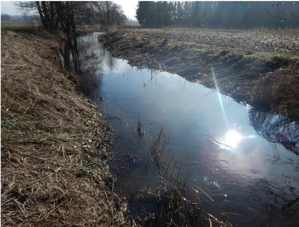
Figur 8 - Torpe kanal i opstrøms retning ved placeringen for ledningsunderboringen.
