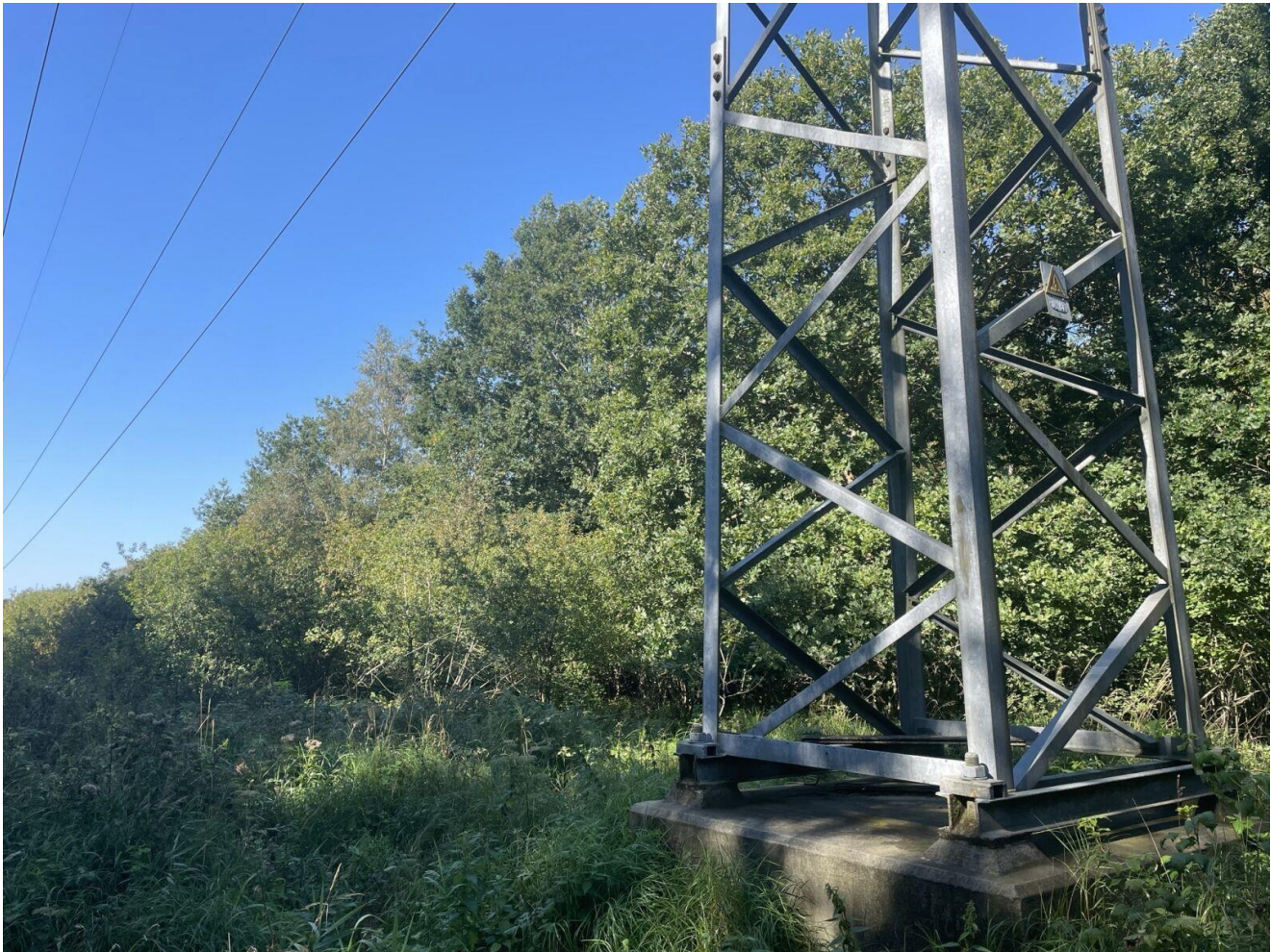
Figur 5: Mast 51. Foto: NIRAS, 8. september 2023.
