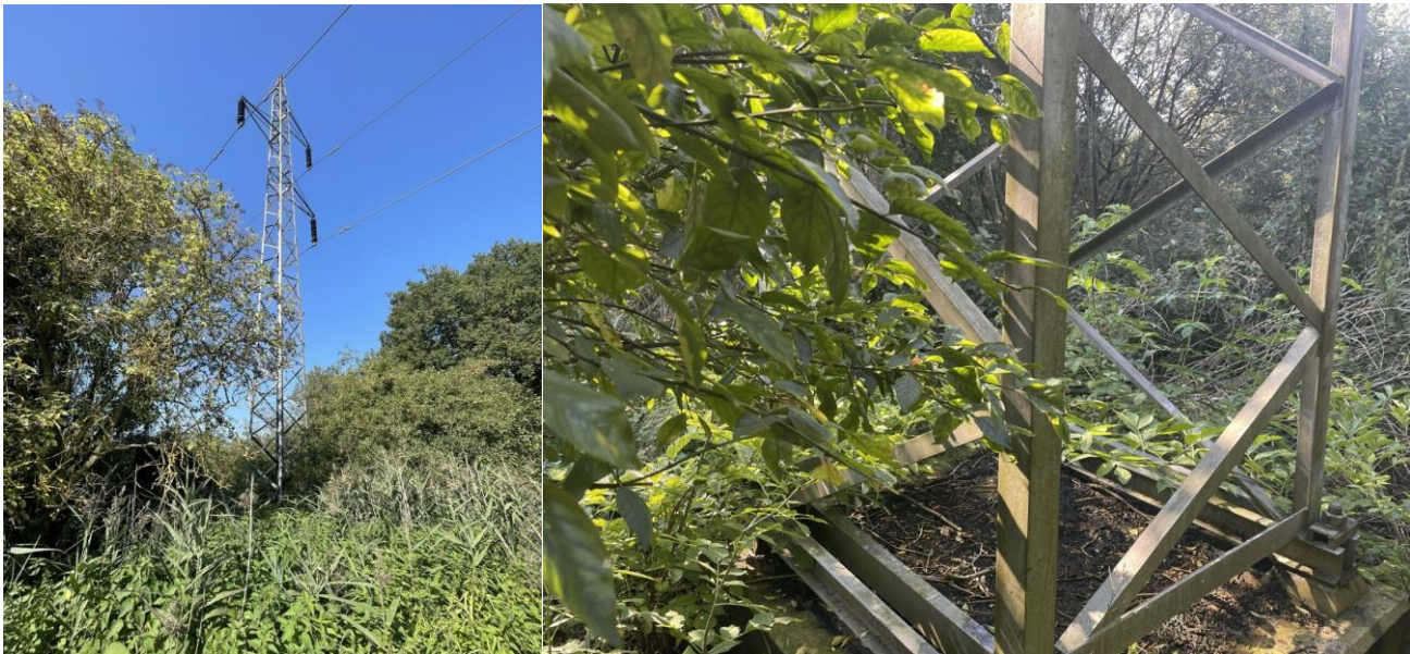
Figur 4: Mast 50. Foto: NIRAS, 8. september 2023.
