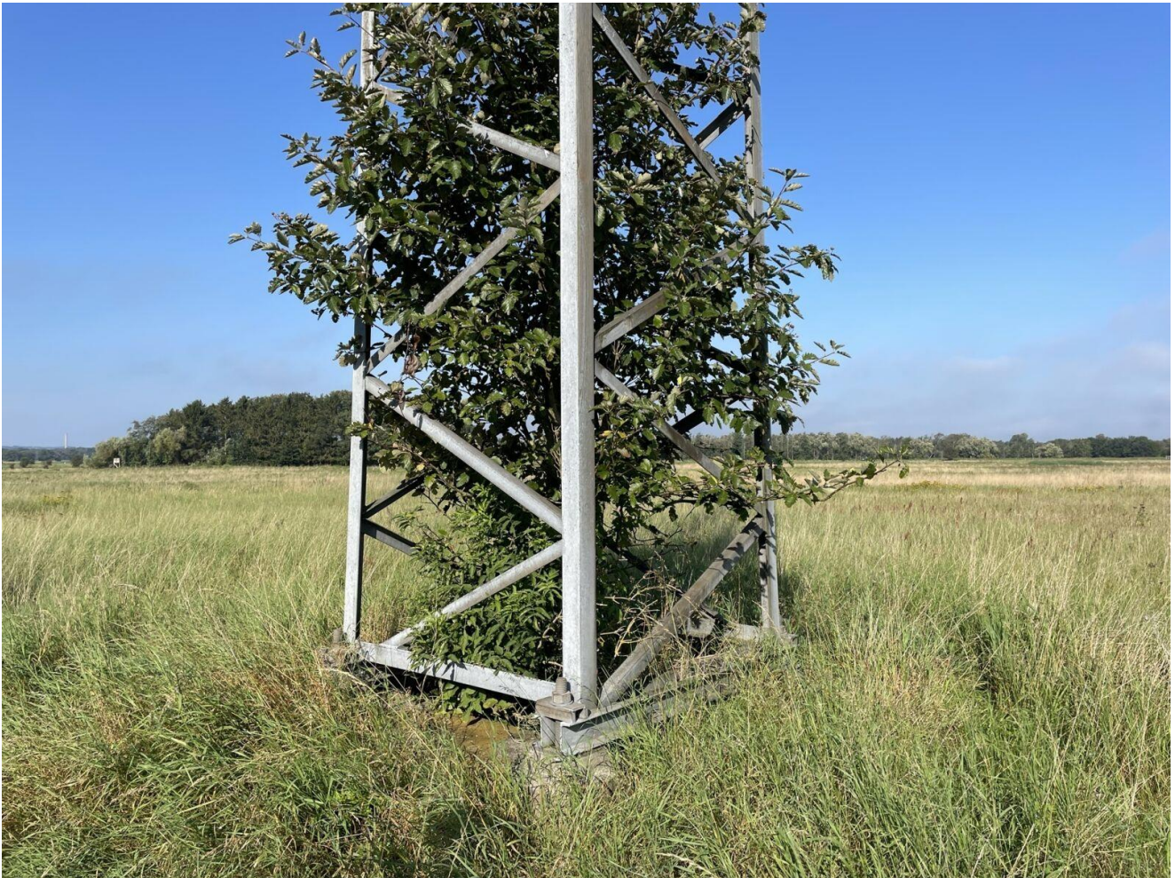
Figur 2: Mast 42. Foto: NIRAS, 8. september 2023.
