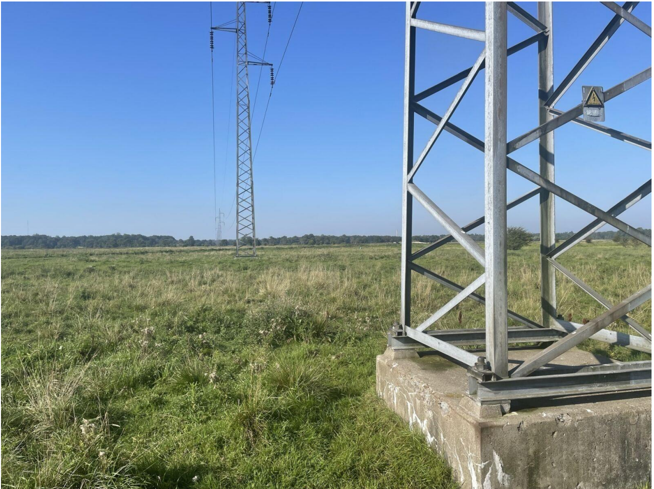
Figur 3: Mast 43 og 44. Foto: NIRAS, 8. september 2023.
