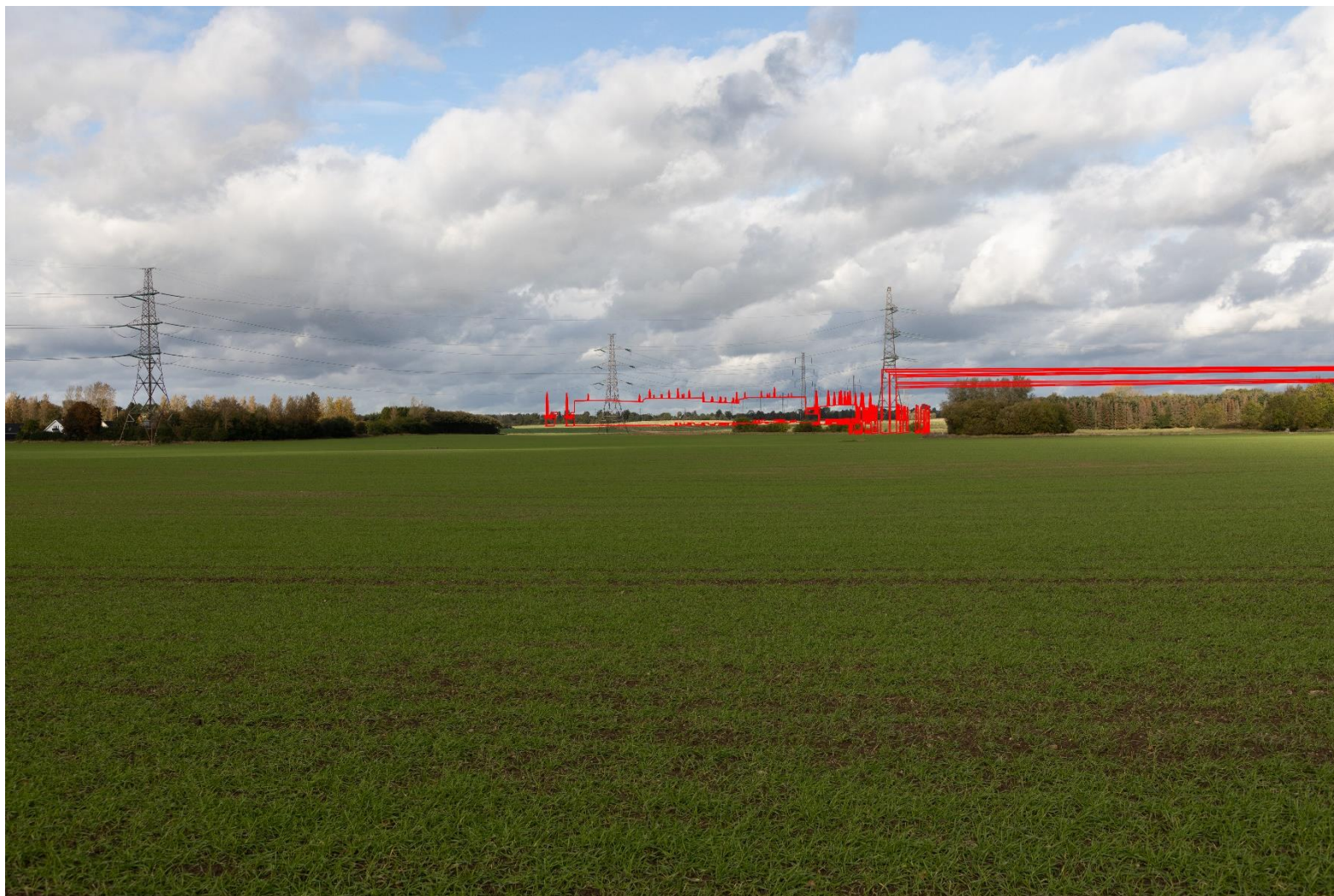
Fotopunkt 9 – Anlæggets omfang vist med rød markering, syd for højspændingsstationen. 35 mm.
