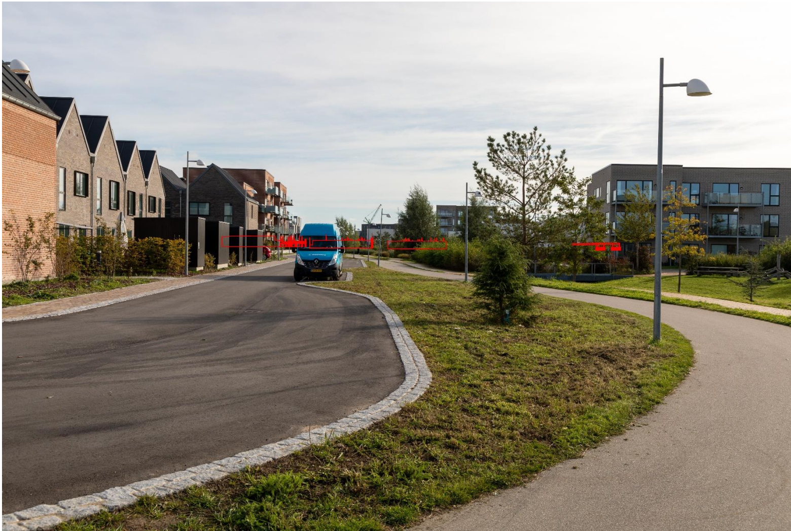
Fotopunkt 8 – Anlæggets omfang vist med rød markering, vest for højspændingsstationen. 35 mm.
