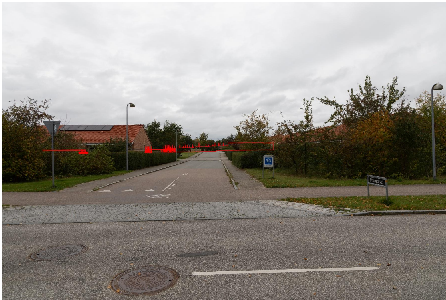
Fotopunkt 6 – Anlæggets omfang vist med rød markering, nordøst for højspændingsstationen. 24 mm.
