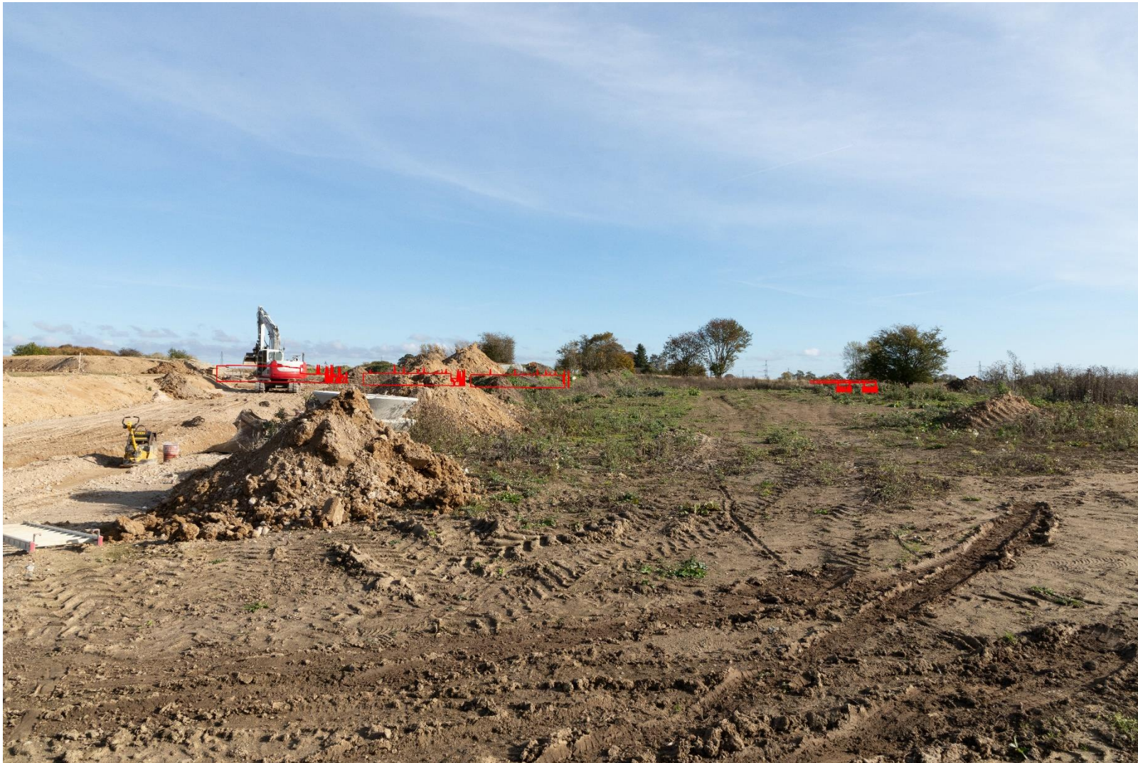
Fotopunkt 10 - Anlæggets omfang vist med rød markering vest for højspændingsstationen. 24 mm.
