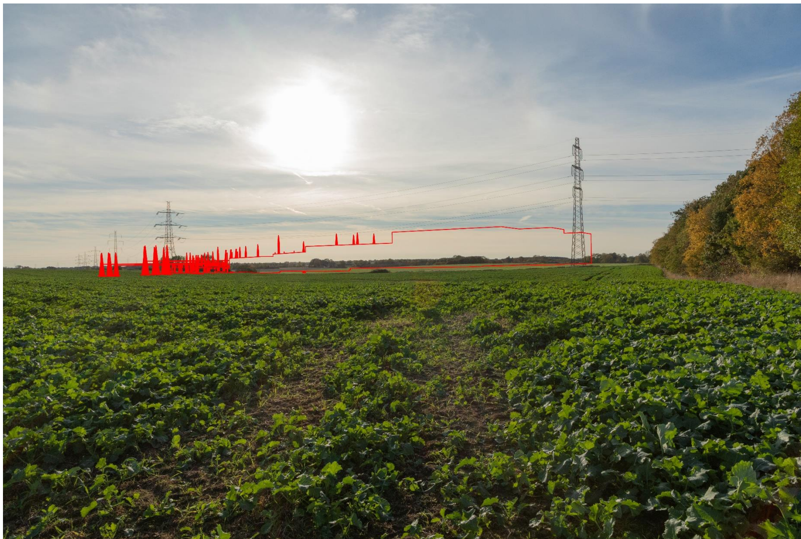
Fotopunkt 11 – Anlæggets omfang vist med rød markering, nordøst for højspændingsstationen. 24 mm.
