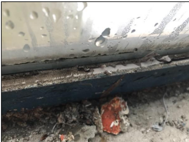
Id: 573, Bygningsdel: Vindue, enkelt-lags, Materiale: Fuge
