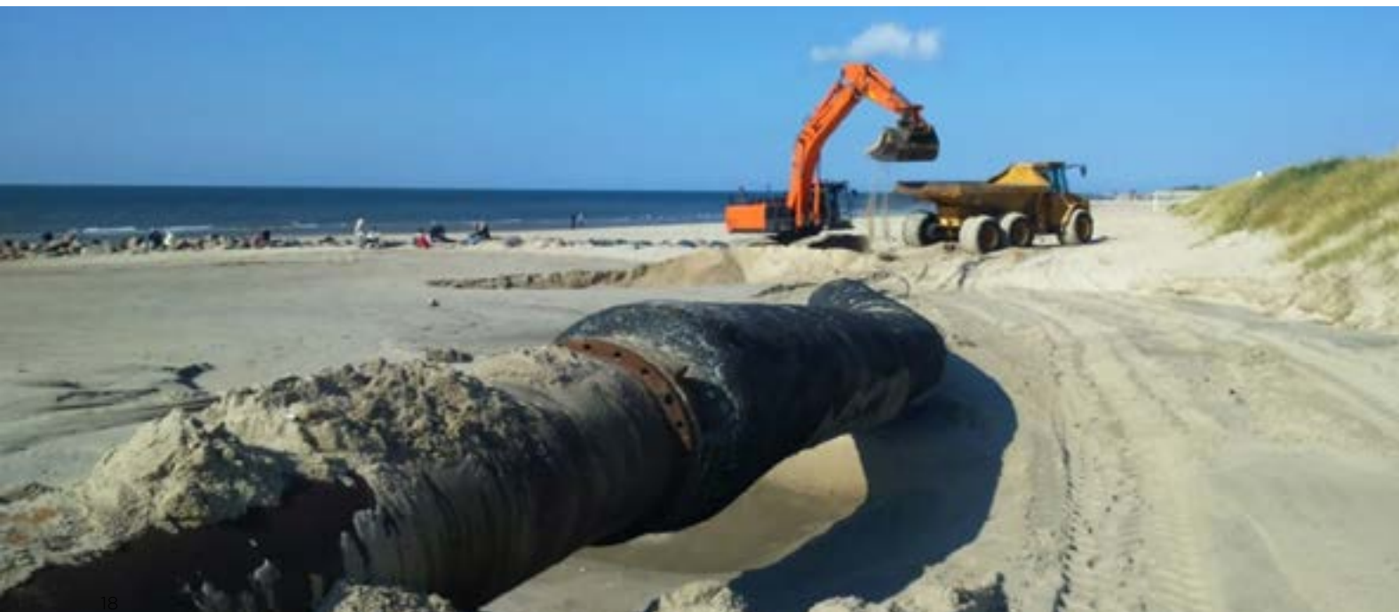
Arbejde med maskiner i forbindelse med strandfodring
