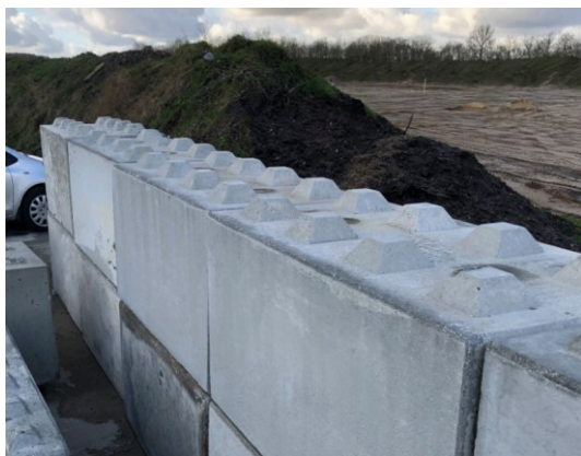
Figur 2.4 Visualisering af megasilo elementer i model 80 (160 x 80 x 80 cm).
