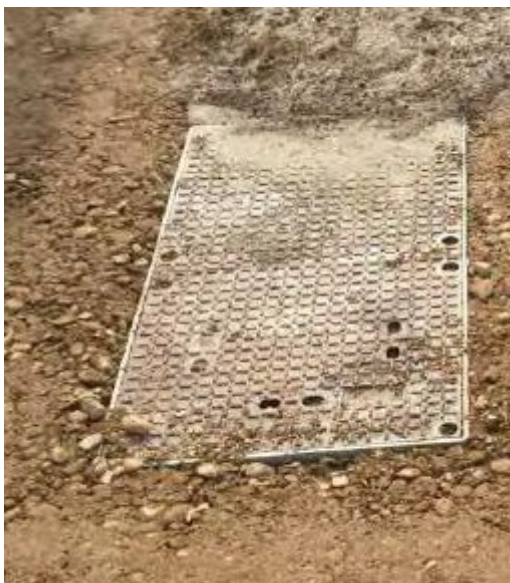
Figur 2-4: Eksempel – foto af dæksel til fiberbrønd i terræn.
