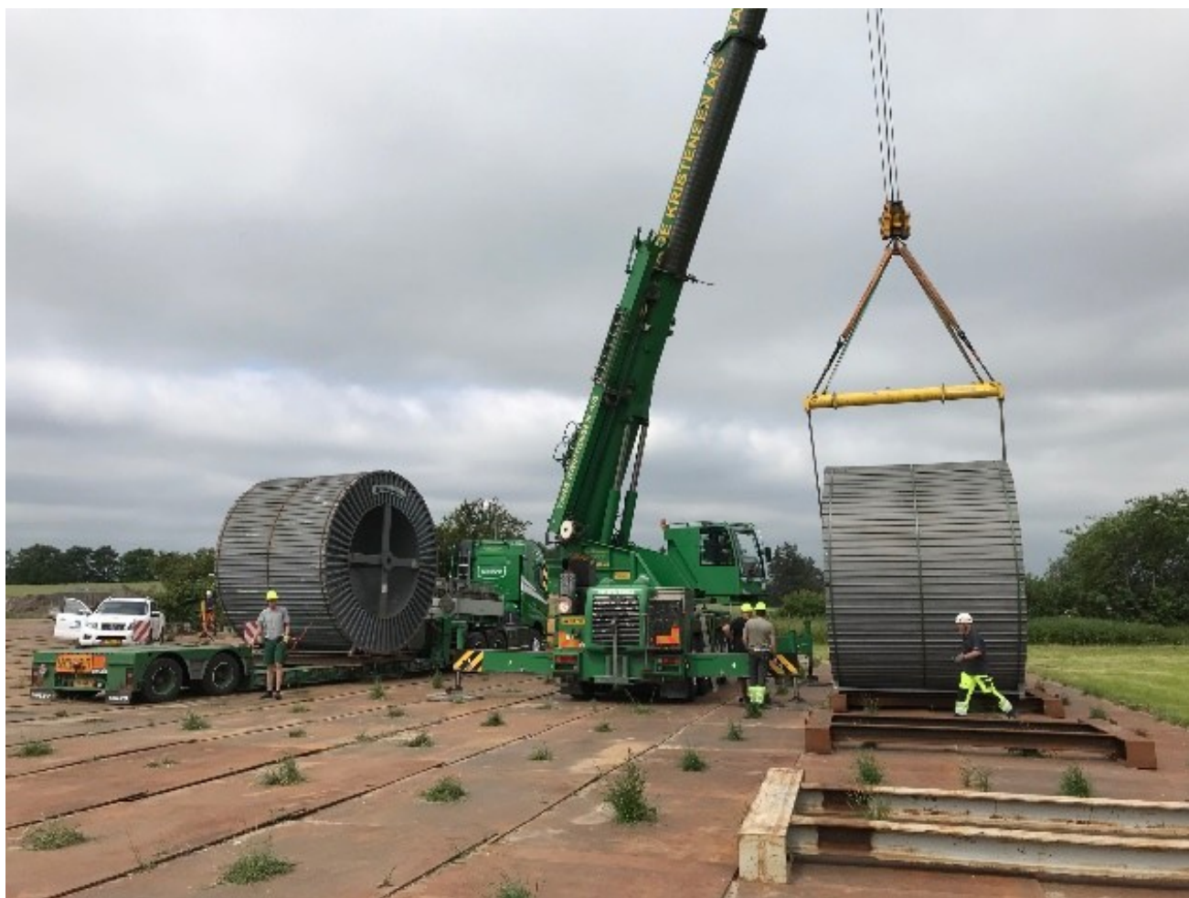
Figur 2-16: Håndtering af kabeltromler på tromleplads.
