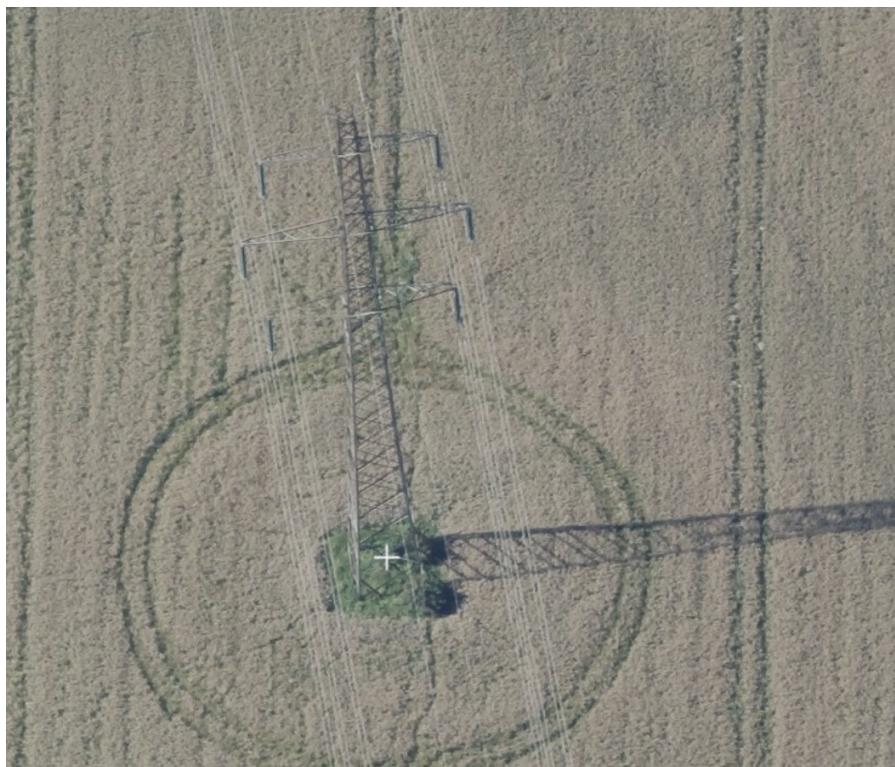
Figur 5-2: Skråfoto af ligeløbsmast med dobbelt luftledningssystem.
