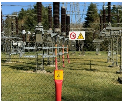
Figur 2-19: Eksempel - foto af markeringspæl og linkboksbrønd.
