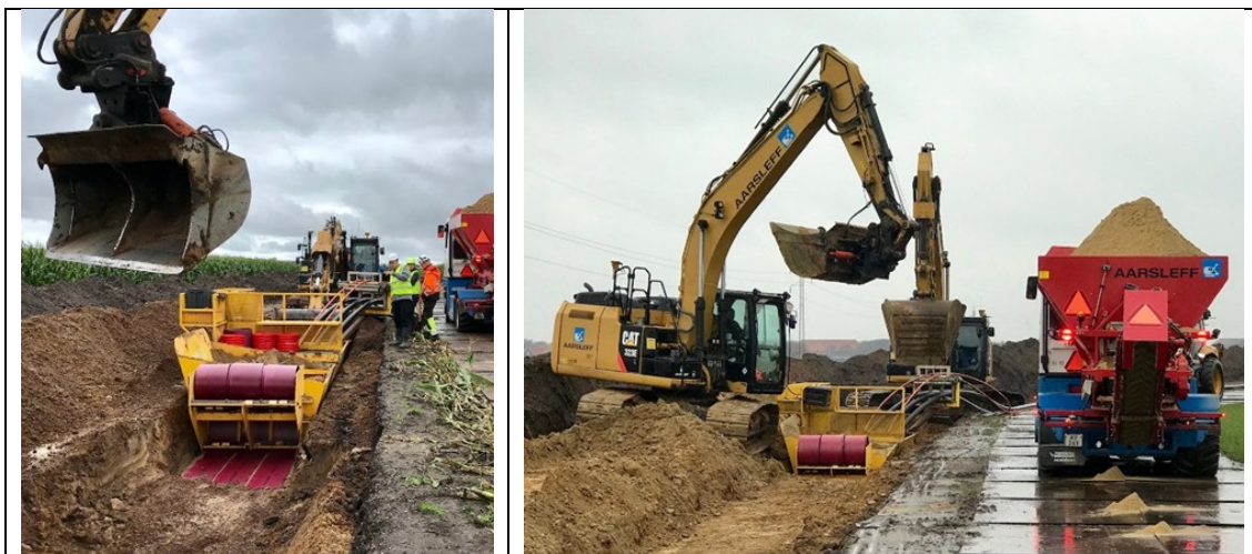
Figur 2-9: Eksempel - foto af gravekasse til etablering af kabelsystem
