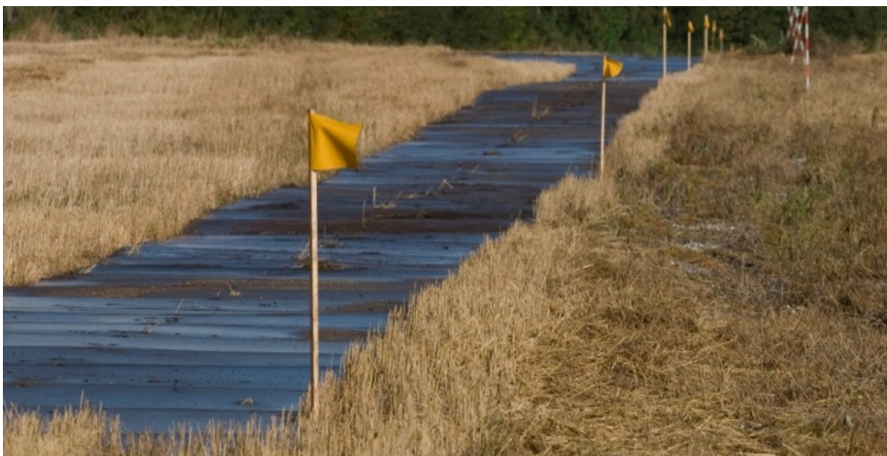
Figur 2-15: Adgangsvej med køreplader.
