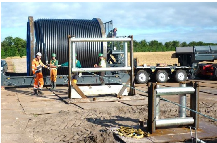
Figur 2-18: Kabeltromle på blokvogn under udtrækning af kabel i kabelgrav.
