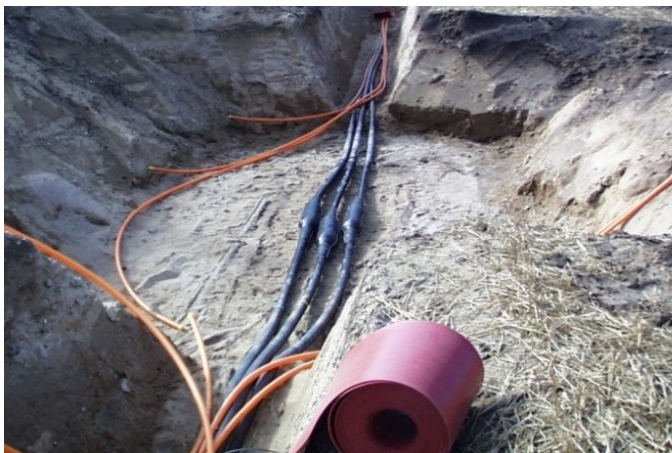
Figur 2-13: De tre fasekabler er muffet sammen og klar til at blive dækket under retablering af muffegrav.
