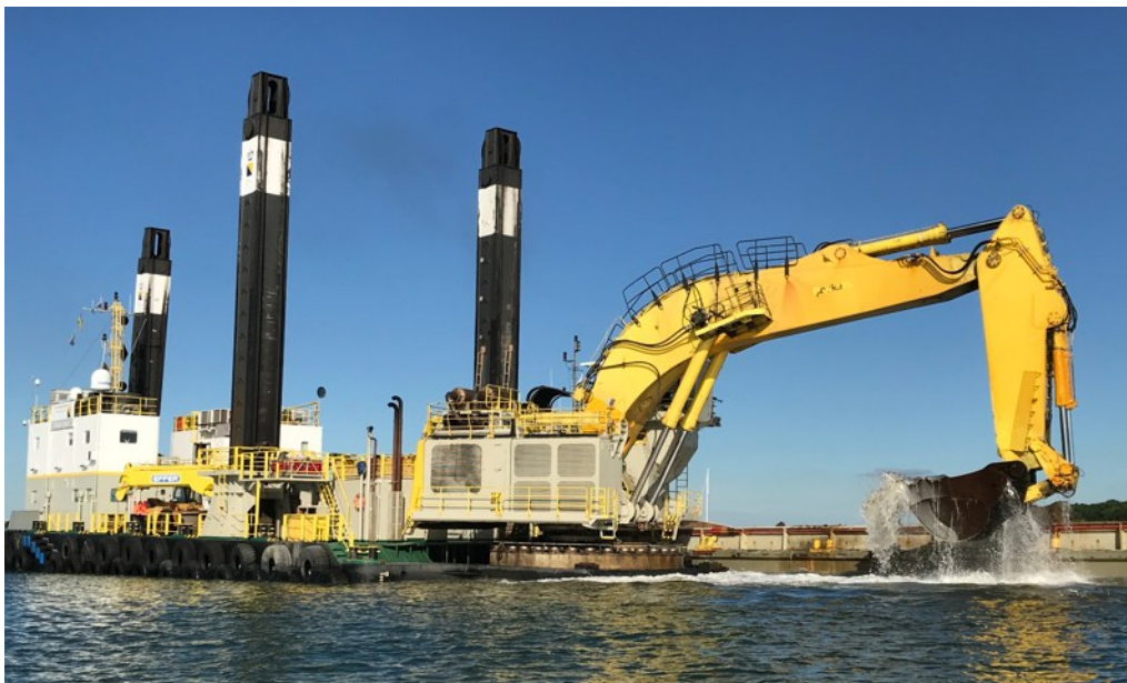
Figur 3-3: Eksempel på en gravemaskine monteret på en pram. Billedet er fra Baltic Pipe.
