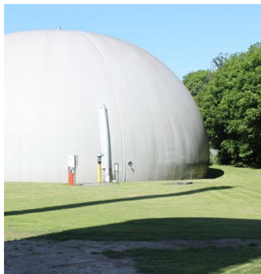
Linkogas, Rødding, gastank på et fælles biogasanlæg.
