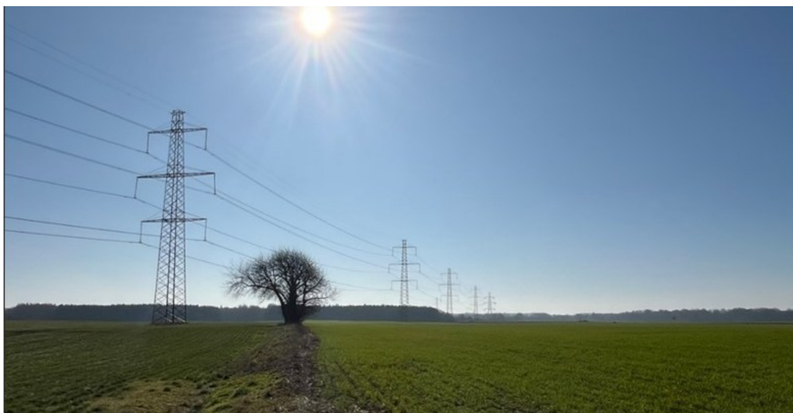
Figur 7-4. De åbne marker syd for overgangsstation Skibstrupgård, med master og højspændingsledninger.
