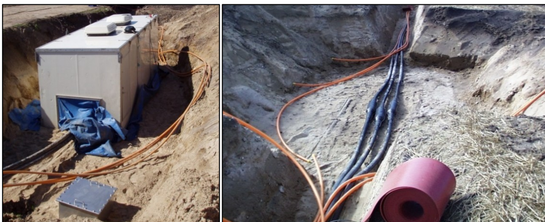
Figur 3-6. Muffecontainer (venstre) og kabler der er muffet sammen (højre).
