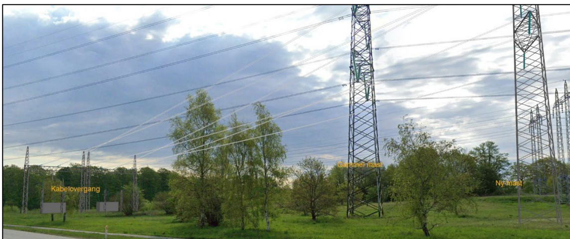
Figur 3-13. Illustration af nye overgangsmaster længst mod venstre, som er forbundet til ny knækmast 43 længst mod højre. På billedet ses også mast 43 (gammel mast) som fjernes.
