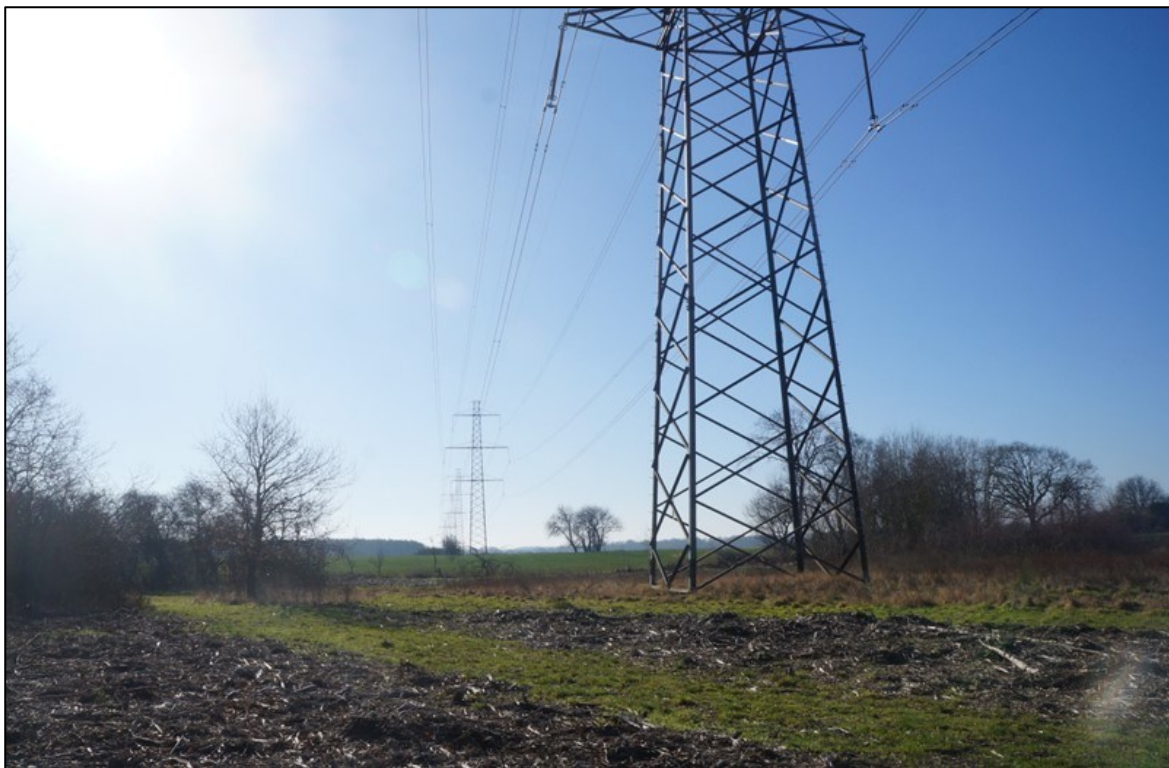
Figur 1-3 Formålet med projektet er at forskønne landskabet i Kongernes Nordsjælland ved at fjerne de eksisterende højspændingsmaster og tilhørende luftledninger.
