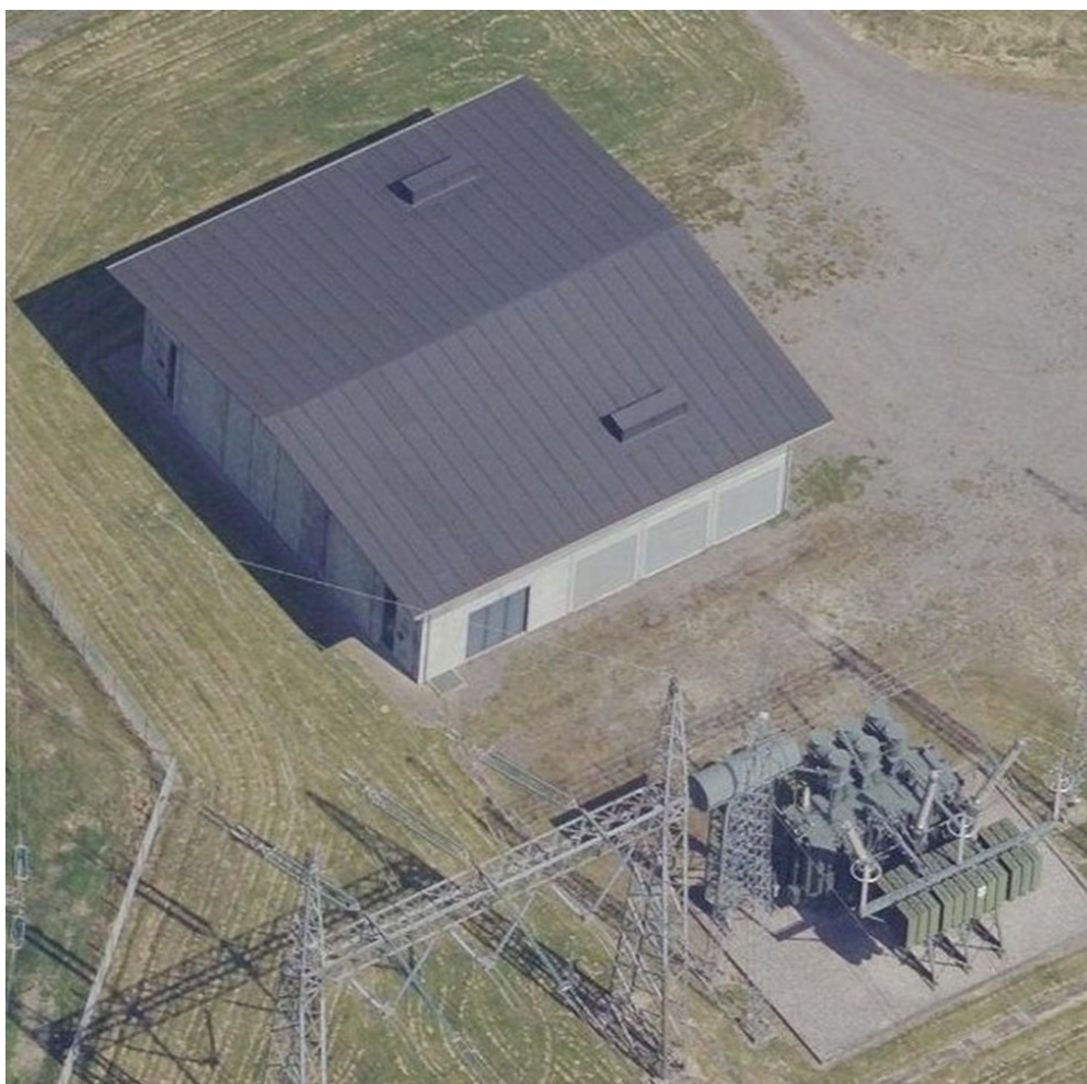
Figur 1-4. Eksempel på en bygning indeholdende et 220 kV-gasisoleret kompakt indendørs koblingsanlæg (GIS)
