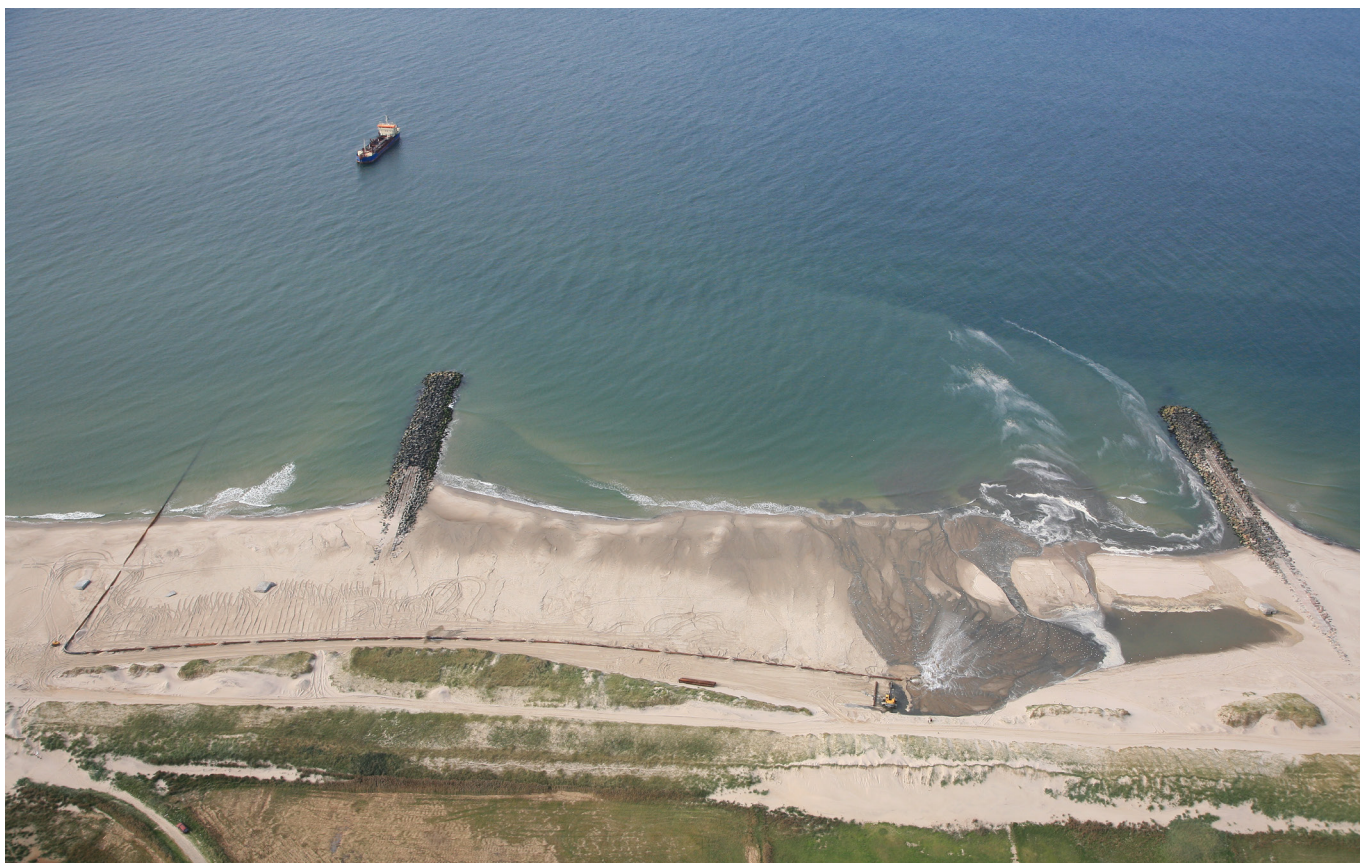
Figur 4. Eksempel på strandfodring. Skibet, der har hentet sand på havet, og pumper det ind på stranden, ses i baggrunden. I forgrunden ses de rør, som sandet bliver pumpet frem i, og ved udløbet ses sandet fordele sig ud over stranden, mens gravemaskinen er klar til at forlænge med flere rør.
