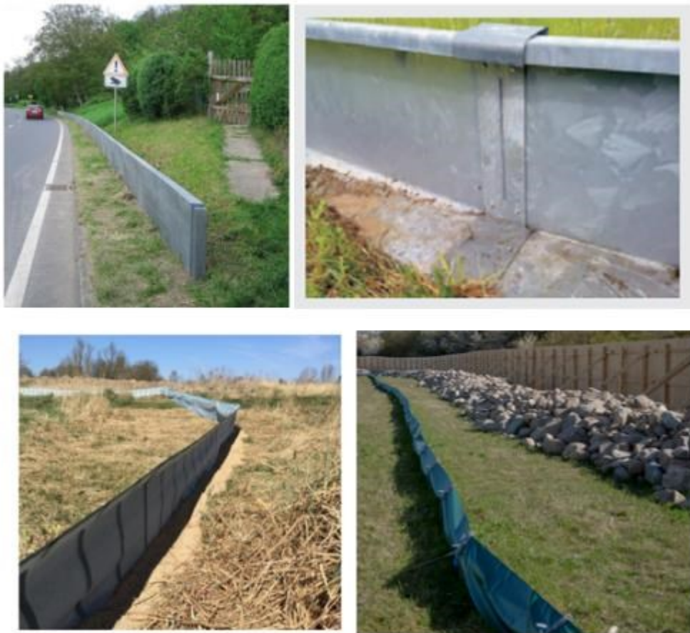
Figur 1-9 På figuren er vist en lodret betonkonstruktion, et metalhegn med ombøjet kant og to forskellige udformninger af mobile hegn af plastik.
