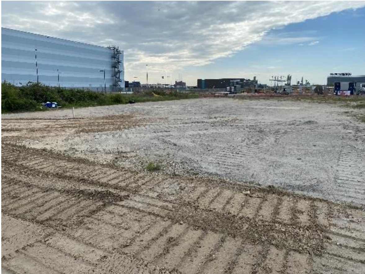
Figur 1-3 Byggeplads 1 ud til Oceanvej (er til venstre mellem det afbillede areal og Unicef højlager). Der er tale om et stærkt modificeret areal blandt andet tæt på en transformerstation, hvor der er etableret paddehegn (mobil type paddehegn af plastik). Nordøst for den planlagte placering af byggepladsen var der opsat tilsvarende paddehegn for foden af høj jordvold. Der er ca. 100 meter væk mindre lavvandede vandansamlinger, der blev besigtiget men vurderes at være uegnede som ynglesteder for grønbroget tudse.
