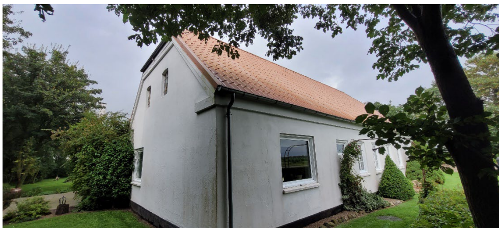
Figur 3-13 Vestlig gavl og sydlig side af Kassøvej 24.
